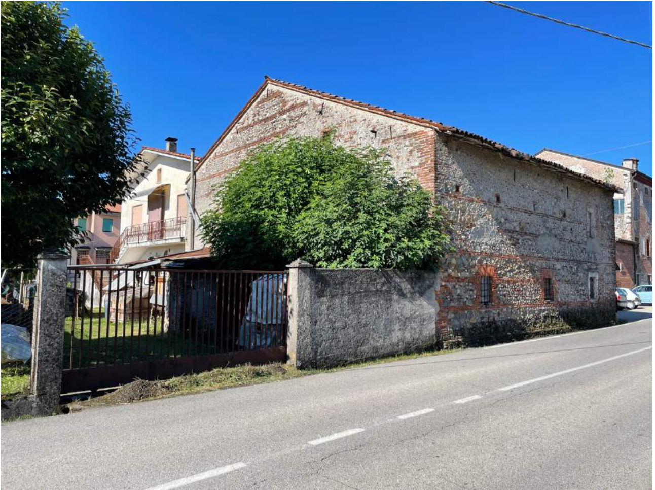
Foto 3. Vista dei lati nord e est da Via Santa Romana.
