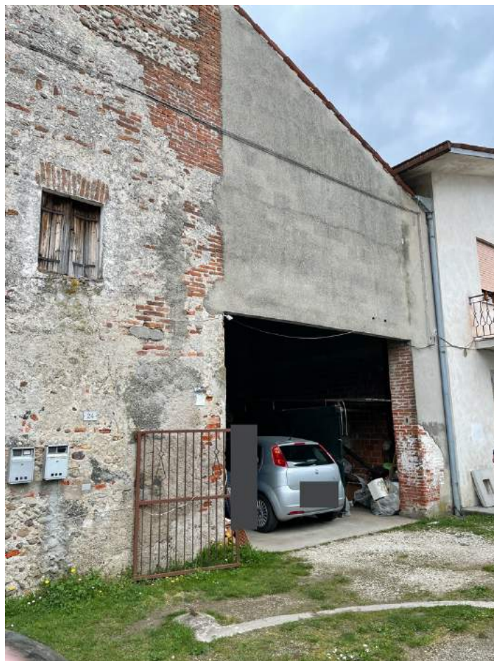
Foto 6. Vista esterna sul lato ovest.
