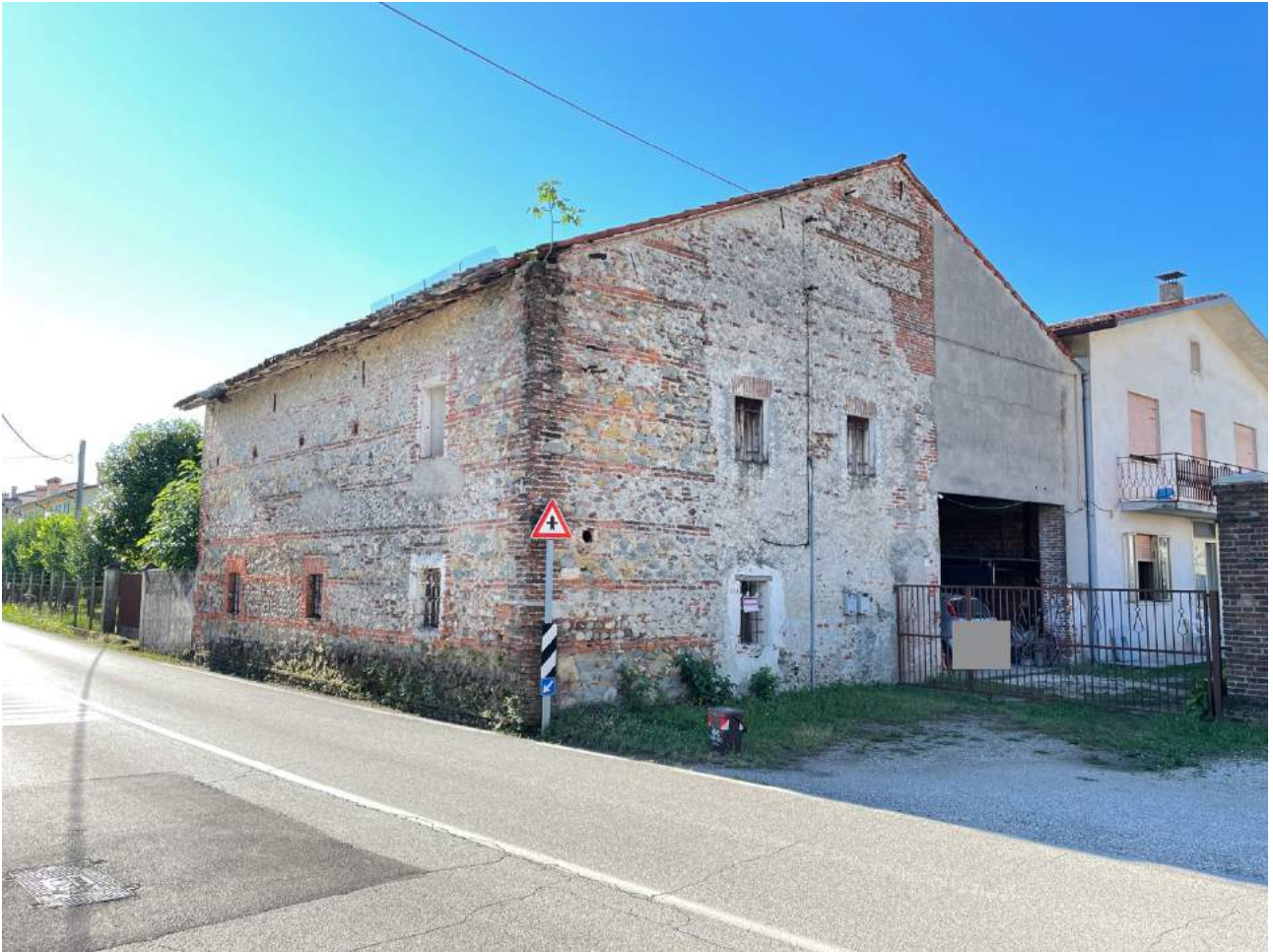
Foto 1. Vista esterna sull'accesso carroia (lati nord e ovest).
