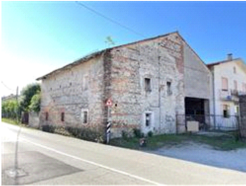
Vista da Via Santa Romana sull'accesso carraio.
