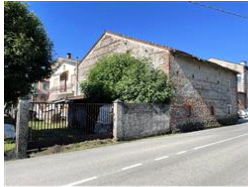
Vista da Via Santa Romana sui lati nord ed est.
