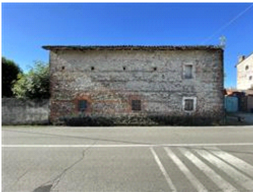
Lato nord da Via Santa Romana.
