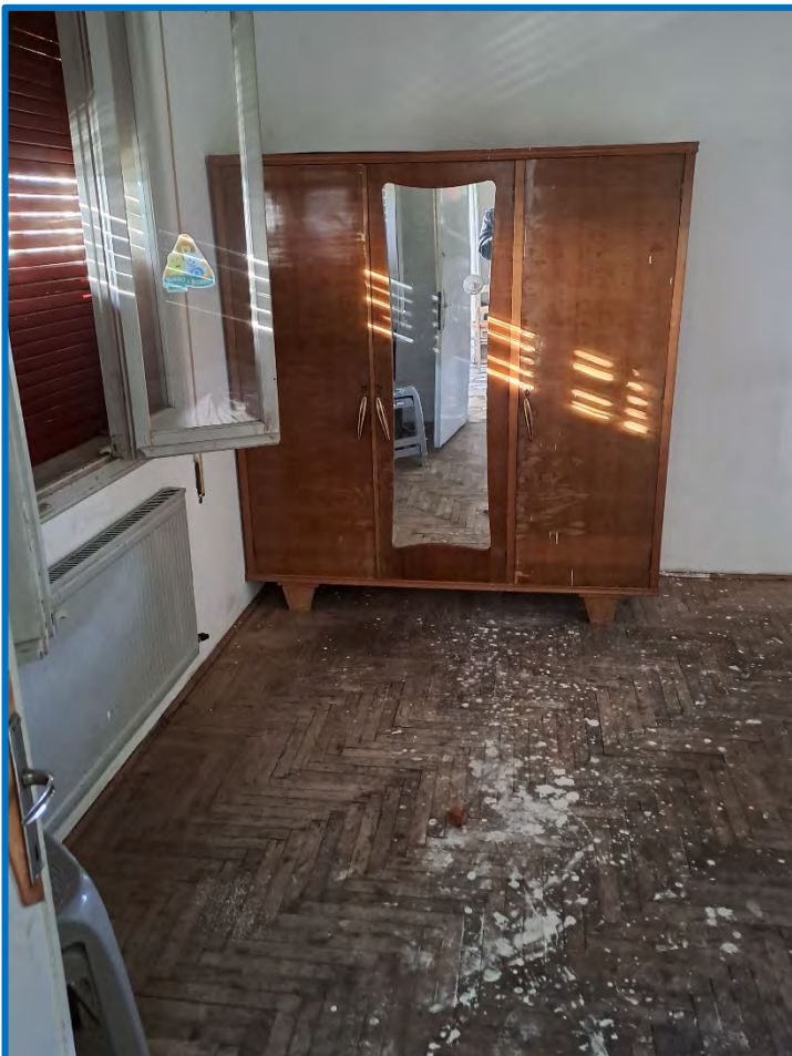
n° 22 – Interno abitazione – piano secondo
