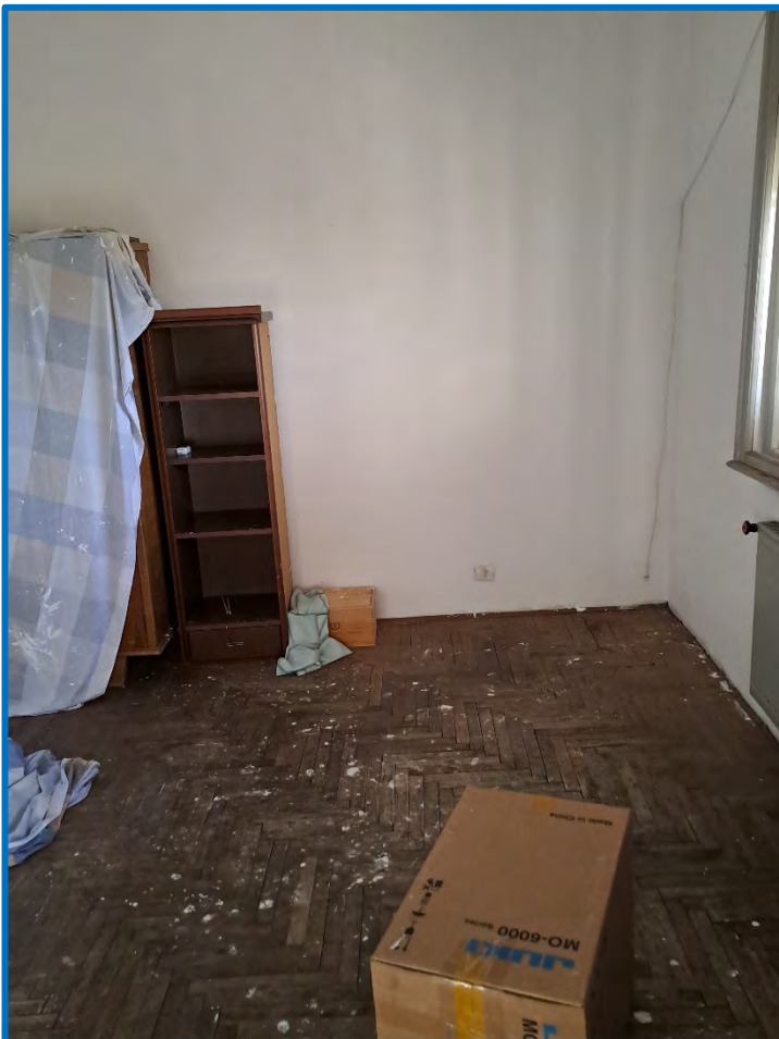
n° 24 – Interno abitazione – piano secondo
