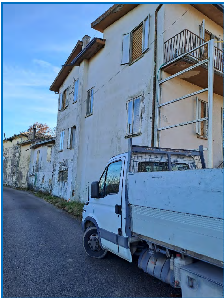
n° 5 Abitazione – esterno nord
