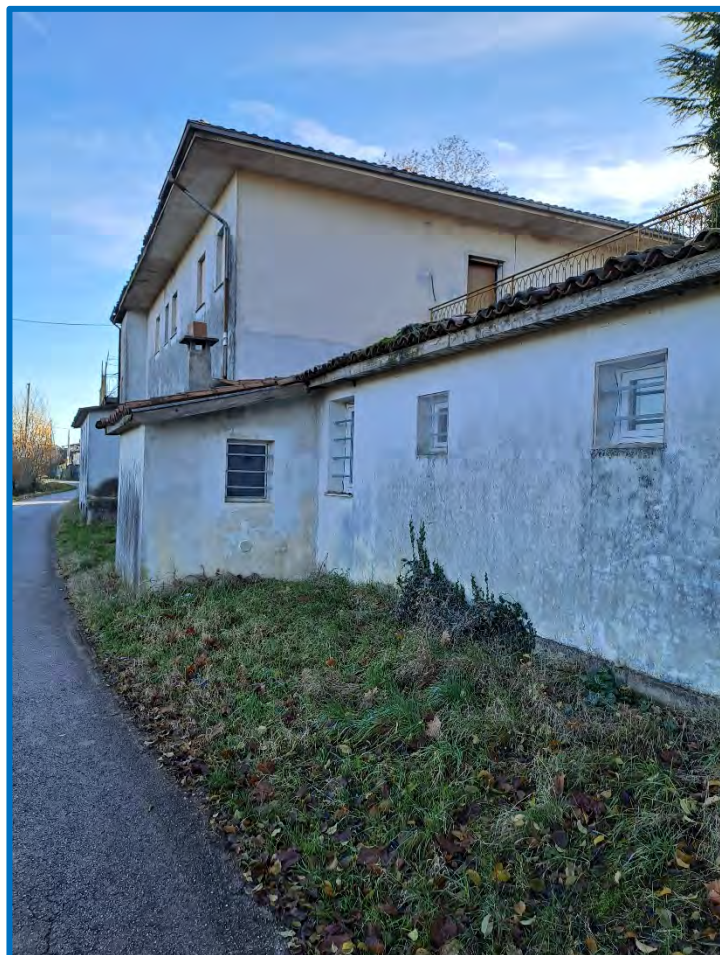
n° 8 - Laboratorio – esterno ovest
