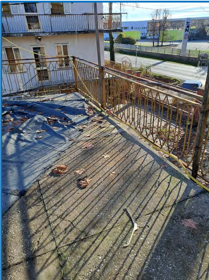
n° 52 – Esterno laboratorio – terrazza est
