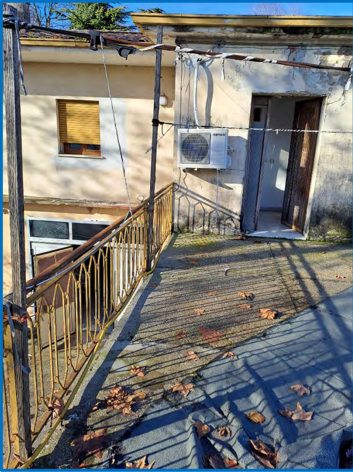
n° 51 – Esterno laboratorio – terrazza est
