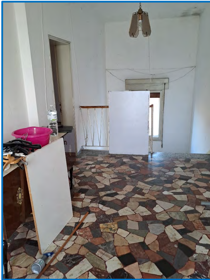
n° 21 - Interno abitazione – piano secondo
