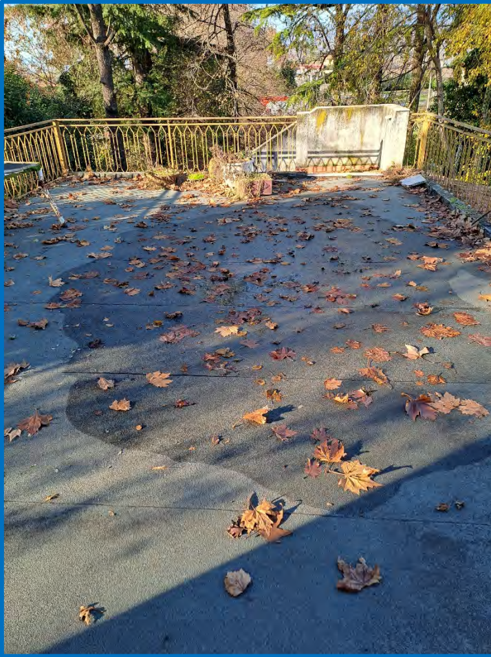
n° 49 – Esterno laboratorio – terrazza ovest
