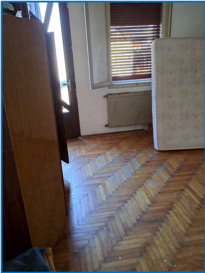
n° 23 – Interno abitazione – piano secondo
