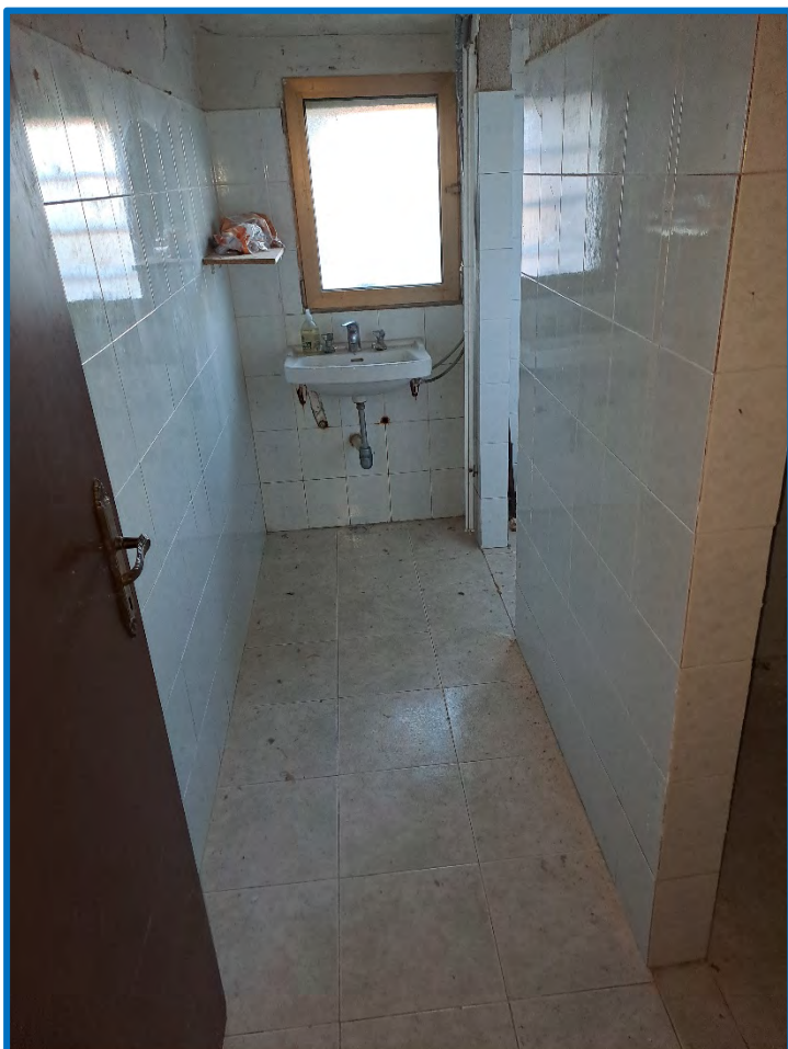
n° 31 – Interno laboratorio – piano terra
