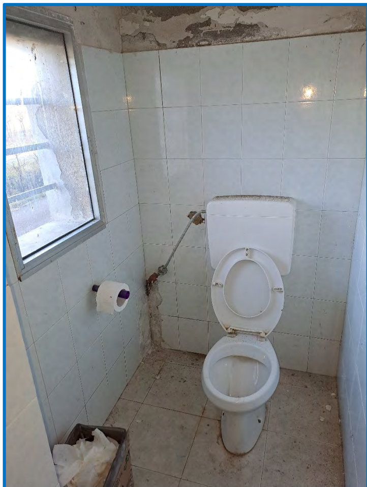
n° 32 – Interno laboratorio – piano terra
