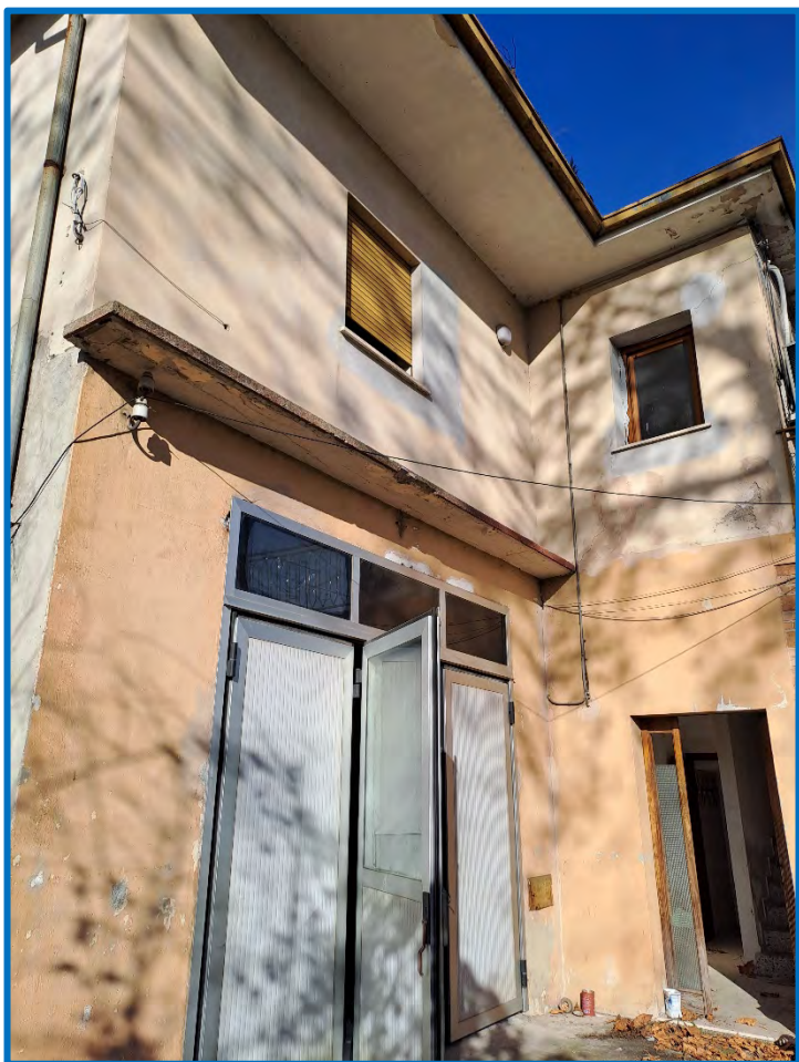
n° 9 Laboratorio – esterno est
