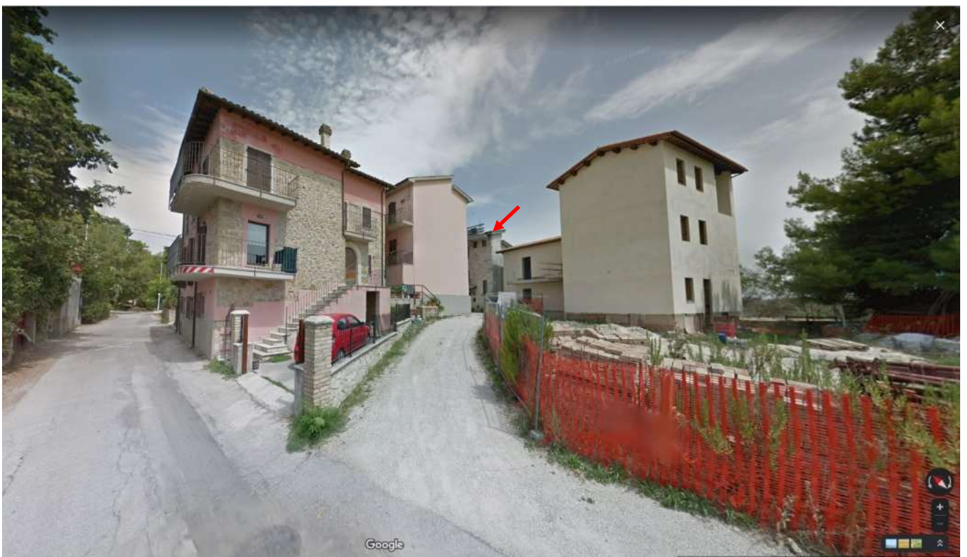
FOTO n°2 - Vista dalla strada - google street view
