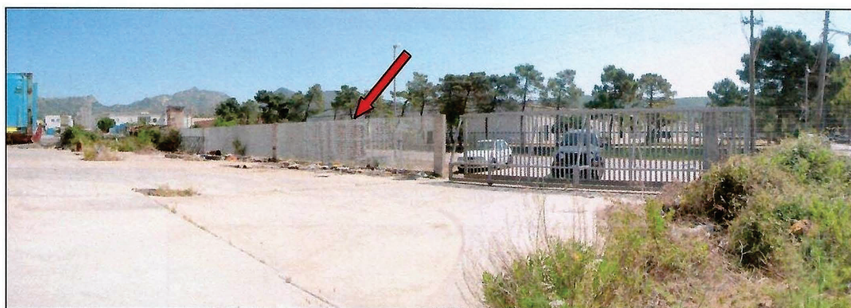
Foto n° 8 – Piazzale, ingresso e recinzione lato est – (freccia: tipologia "Orsogrill").
