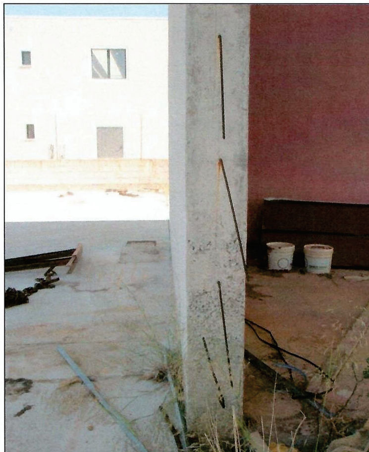
Foto n° 13 - Particolare parete esterna capannone in c.a. (h= ml. 4.00).
