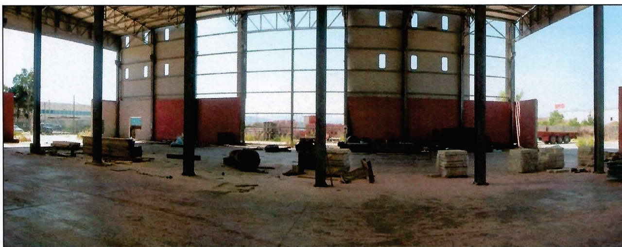
Foto n° 2 – Veduta Parete Laterale Interna – (lato Sud).
