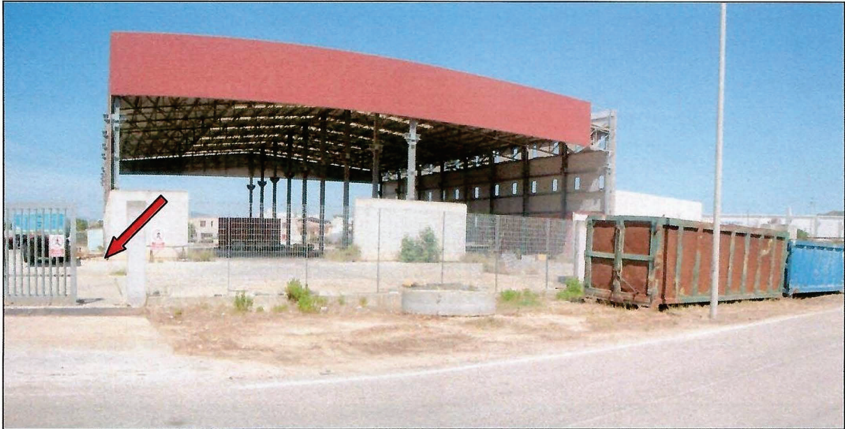
Foto n° 4 – Prospetto Est (via Senegal) - (freccia: portone d'ingresso).
