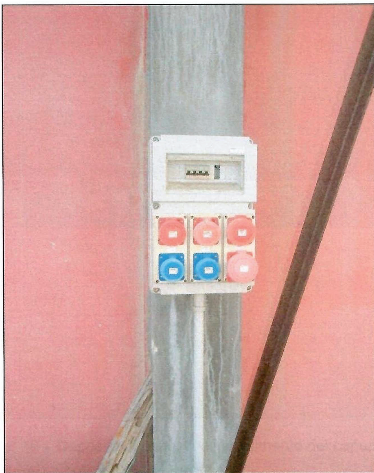
Foto n° 14 – Tipologia prese elettriche.
