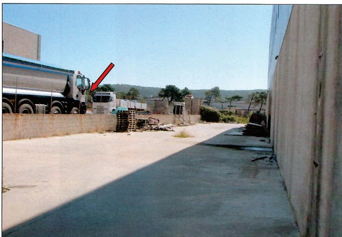
Foto n° 9 – Recinzione e piazzale lato nord – (freccia: muretto e rete metallica).
