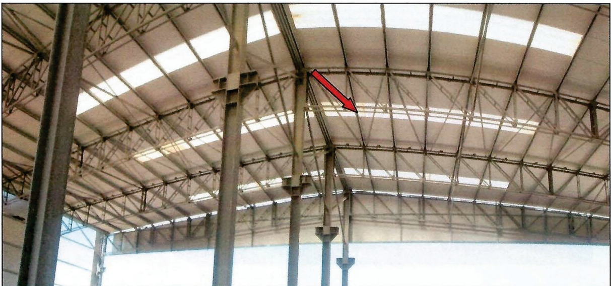
Foto n° 6 – Particolare copertura – (freccia: capriate metalliche).
