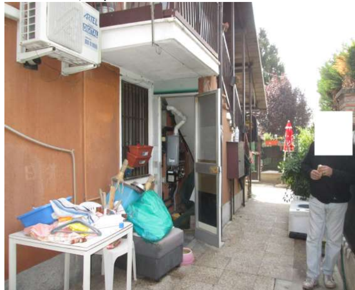
4) Locale ripostiglio fruito a locale tecnico ricavato nel sottoscala
