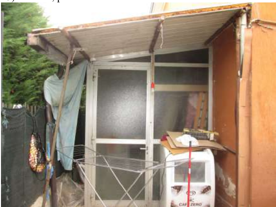
17) Manufatto posto sul retro da rimuovere
