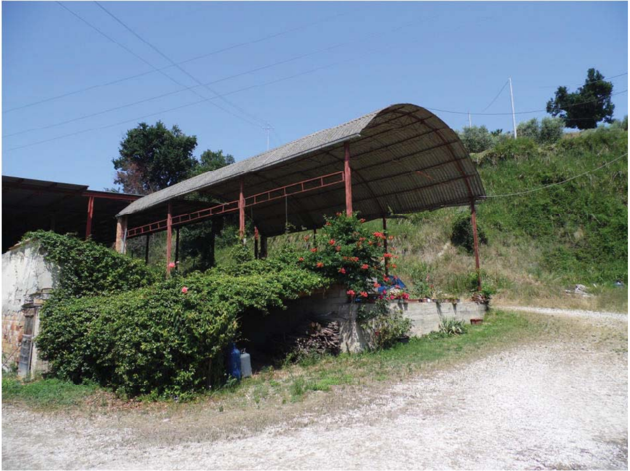
F. 41 - P. 75 - sub 2 - corpo E
