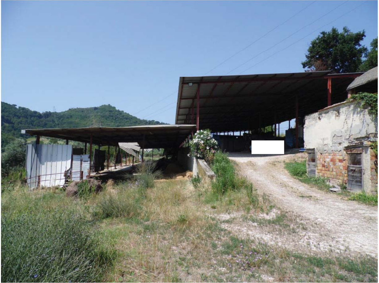
F. 41 - P. 75 - sub 2 - corpo E
