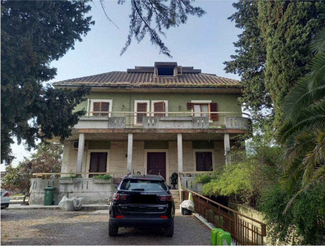
Foto 1 – vista esterna dell’immobile – si noti l’infisso dell’abbaino al piano sottotetto
