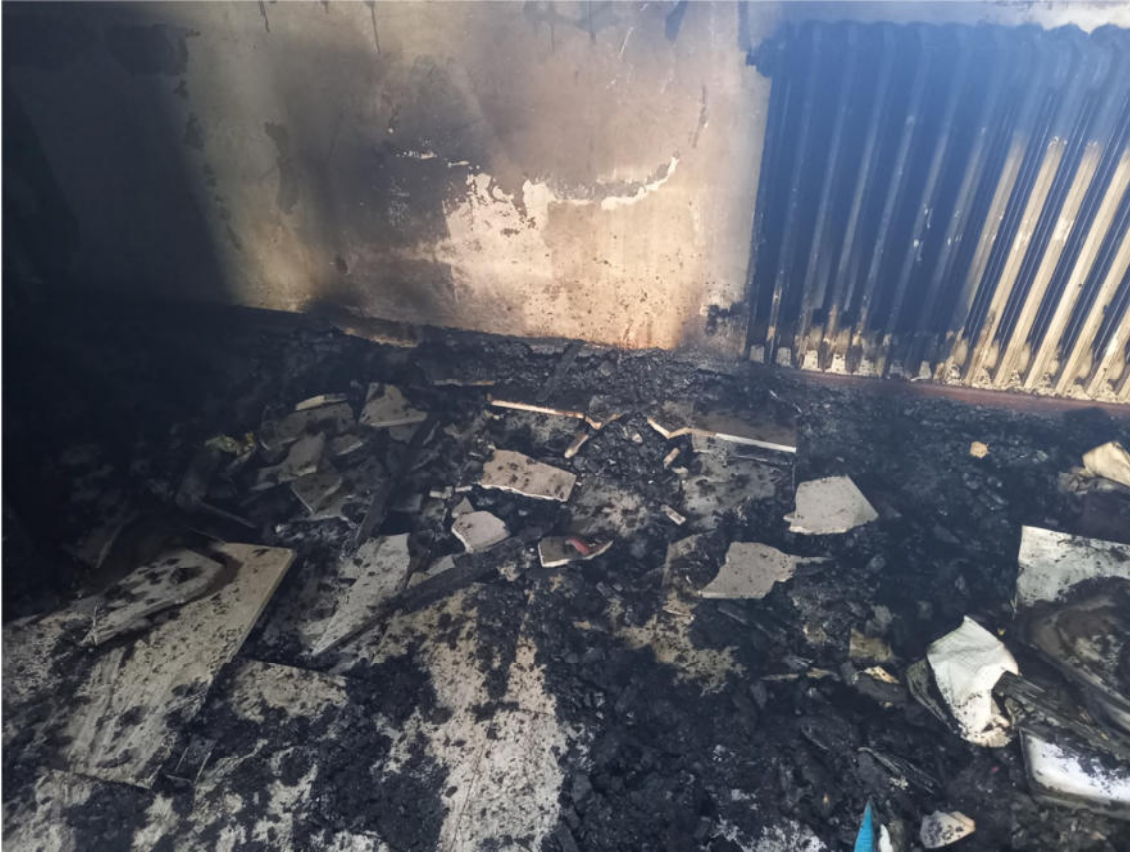
Foto 7 – particolare pavimento distaccato al piano sottotetto
