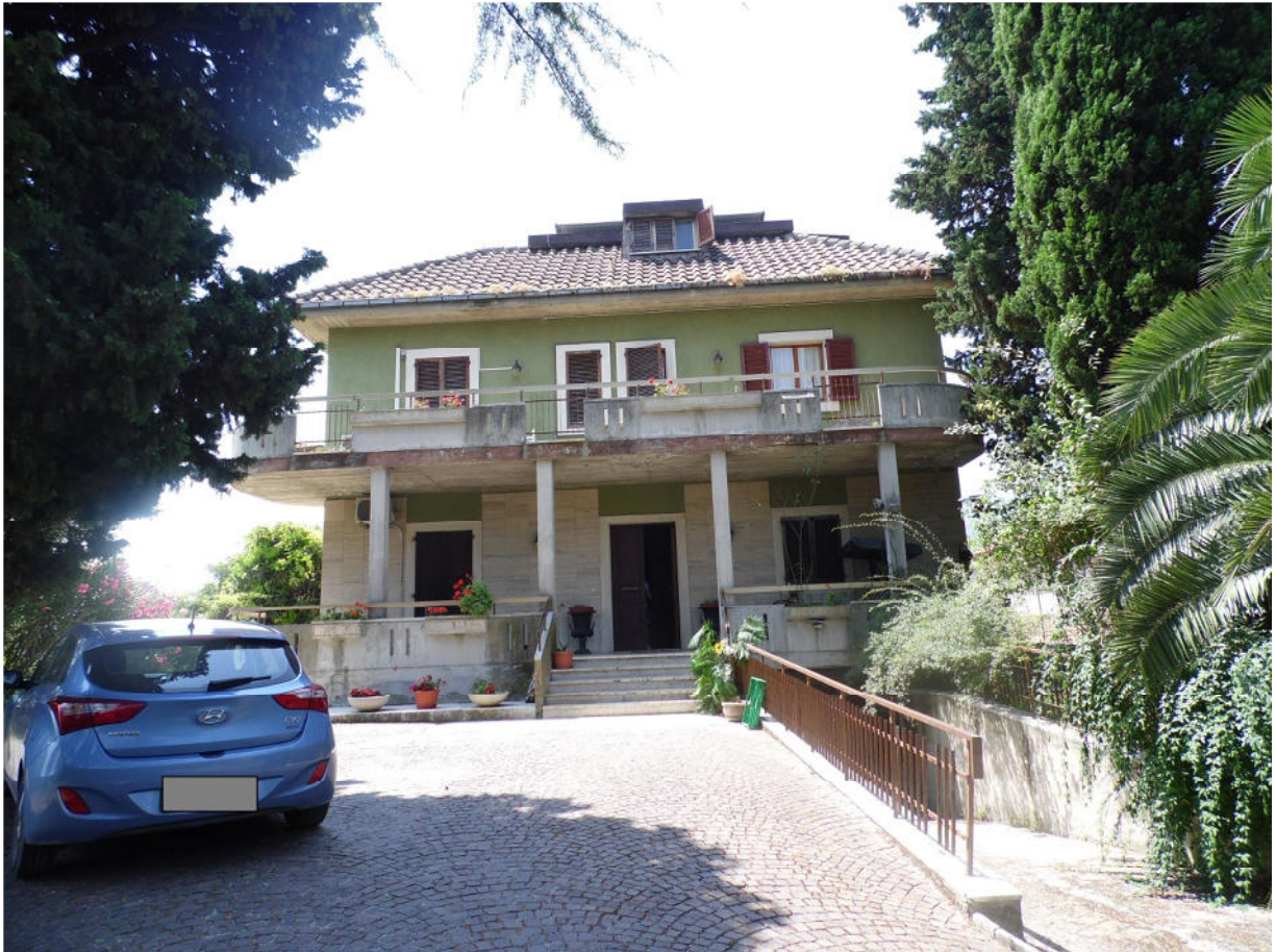
Villa Monticelli - F. 74 - P. 72 – vista esterna
