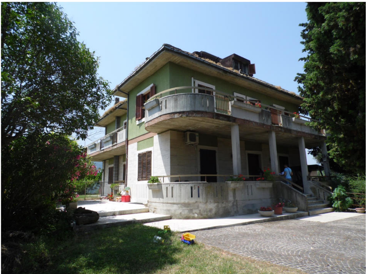
Villa Monticelli - F. 74 - P. 72 – vista esterna
