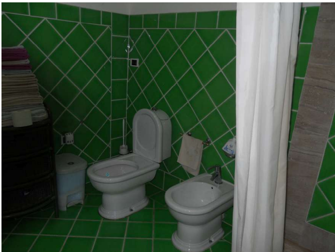
Foto 15: vista del bagno. Il vano è stato ampliato inglobando un ripostiglio. Opere non autorizzate.
