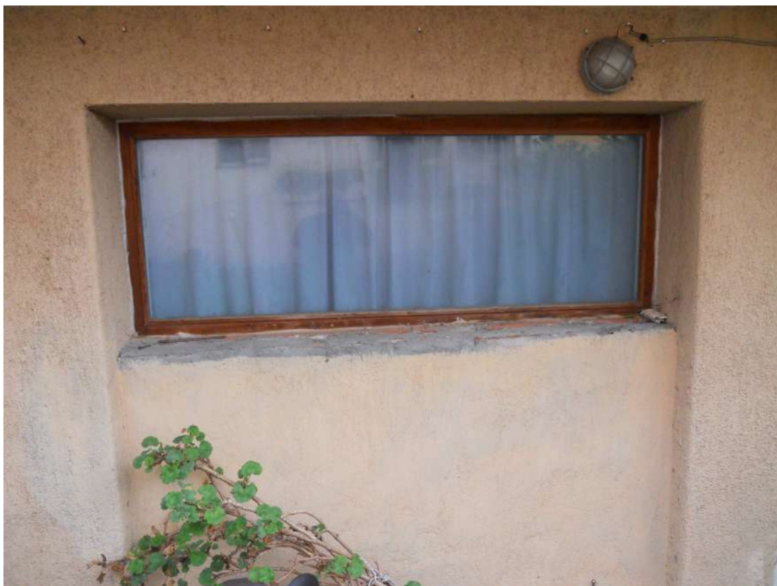
Foto 5: vista della chiusura del varco di accesso al cortile. Via Stazione.
