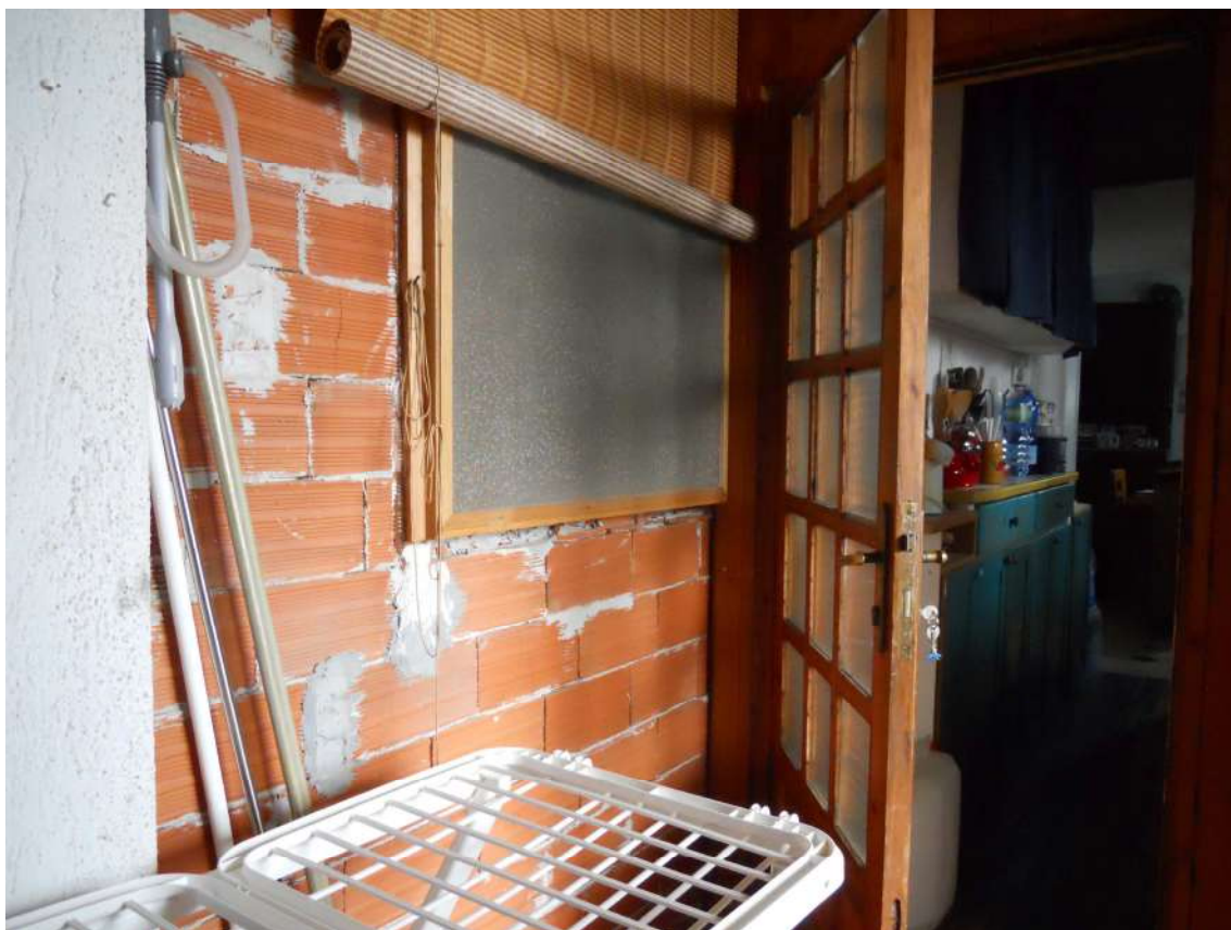
Foto 19: vista della chiusura in laterizio del passaggio verso il cortile. Sulla destra porta di uscita dal cucinotto verso il cortile.
