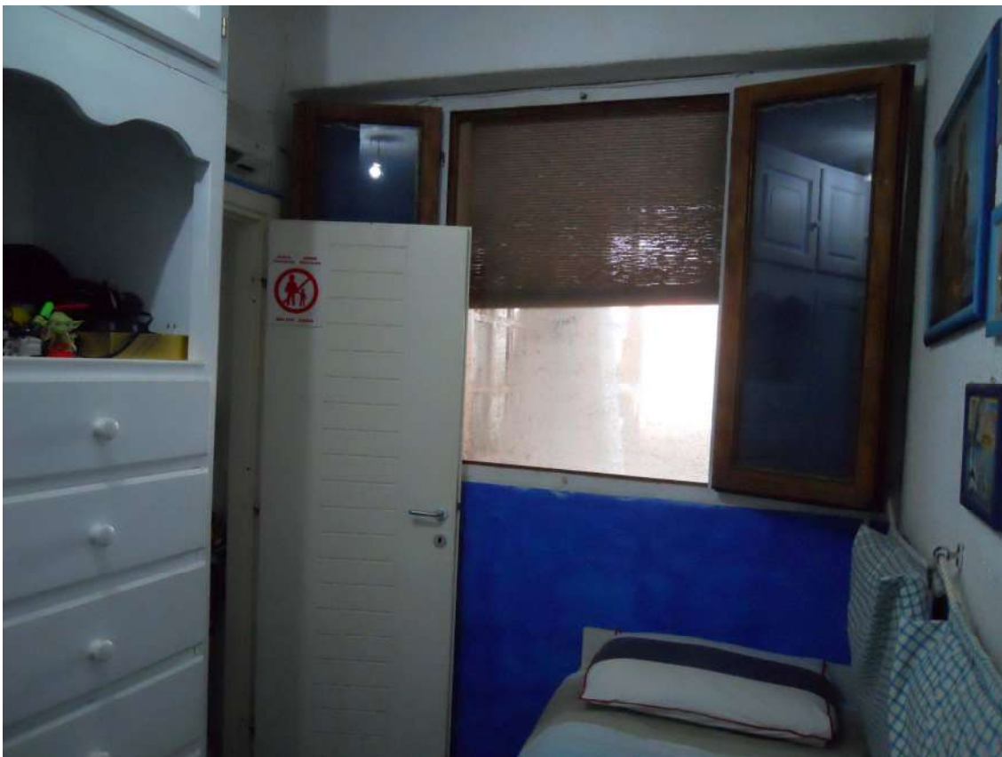
Foto 13: vista della cameretta ottenuta dalla chiusura del varco di accesso al cortile. Opere non autorizzate.
