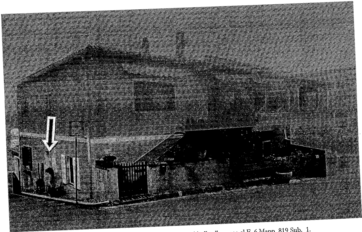
Scorcio del fabbricato Via Po angolo Via Stazione. Con la freccia si indica l'accesso al F. 6 Mapp. 819 Sub. 1.
