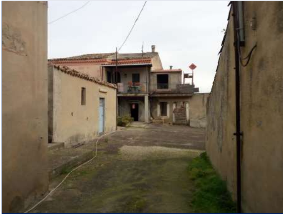
Foto 66 – Imm. 5 – Parte interna alla corte, ad uso comune dei diversi immobili presenti.
