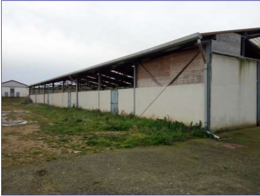
Foto 34 – Imm. 3 – Deposito . Prospetto laterale Nord.
