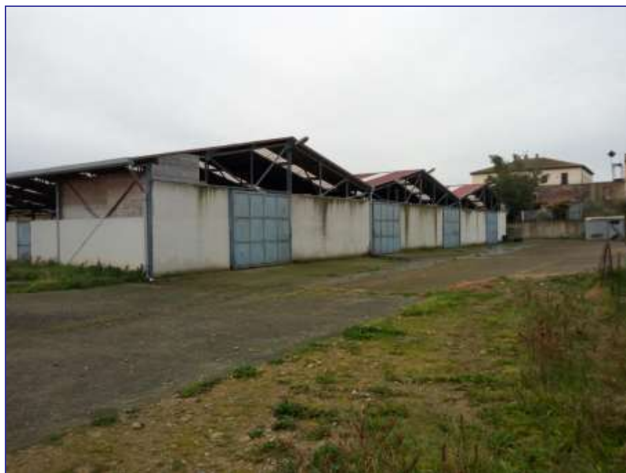
Foto 33 – Imm. 3 – Deposito. Prospetto principale con accesso dagli spazi esterni comuni.
