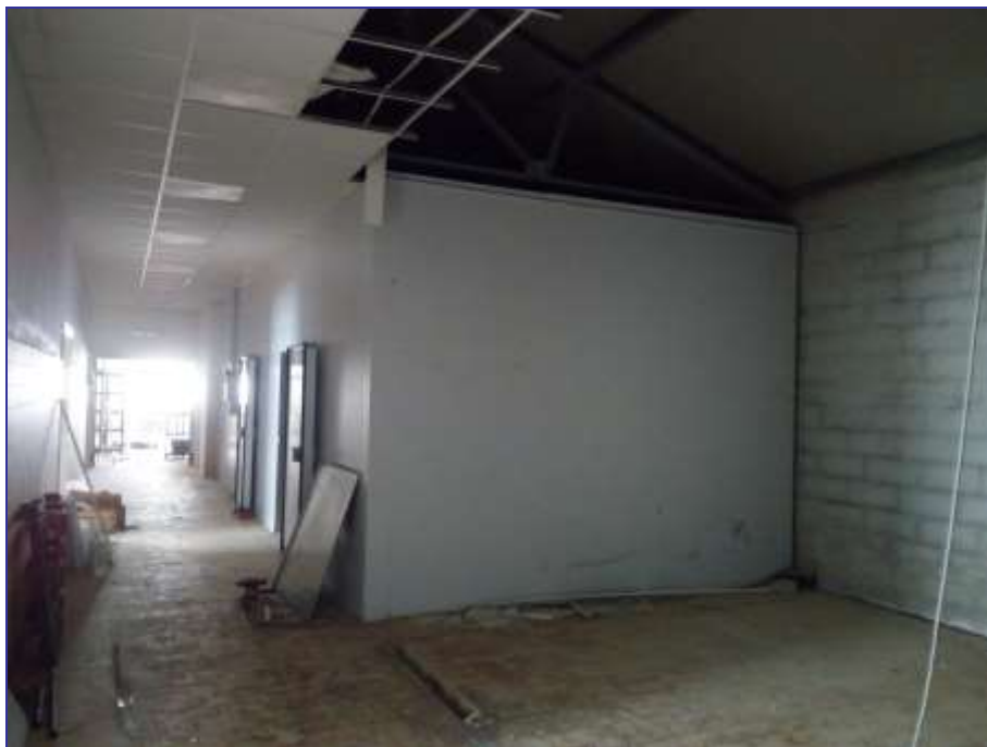
Foto 50 – Imm. 3 – Caseificio . Zona centrale in prossimità del corridoio, destinata all'installazione delle celle frigo.
