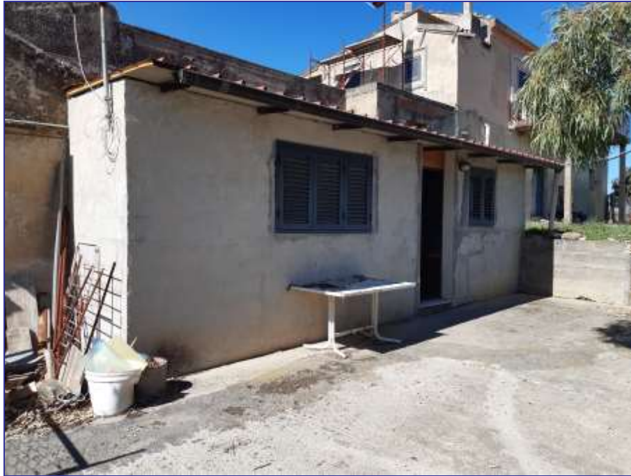
Foto 27 – Imm. 2 – Alloggio custode . Altra visione del prospetto alloggio custode.
