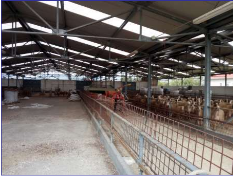
Foto 38 – Imm. 3 – Deposito. Altra immagine interna.
