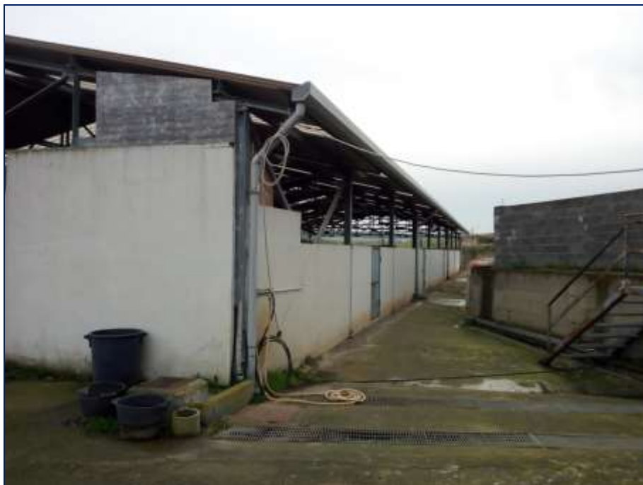
Foto 35 – Imm. 3 – Deposito . Prospetto laterale Sud in adiacenza all'Imm. 2 se pur in altro livello.
