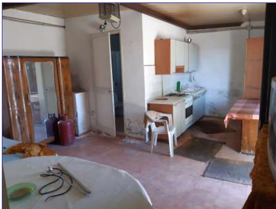
Foto 30 – Imm. 2 – Alloggio Custode . Spazio interno dedicato a cucina e locale bagno adiacente.
