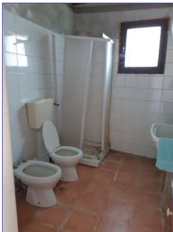
Foto 31 – Imm. 2 – Alloggio Custode . Locale bagno.
