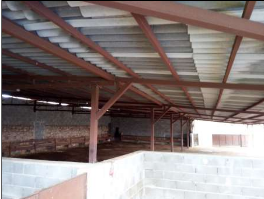
Foto 21 – Imm. 2 – Ovile . Immagine interna dell'ovile con pilastri di sostentamento della copertura in pannelli.
