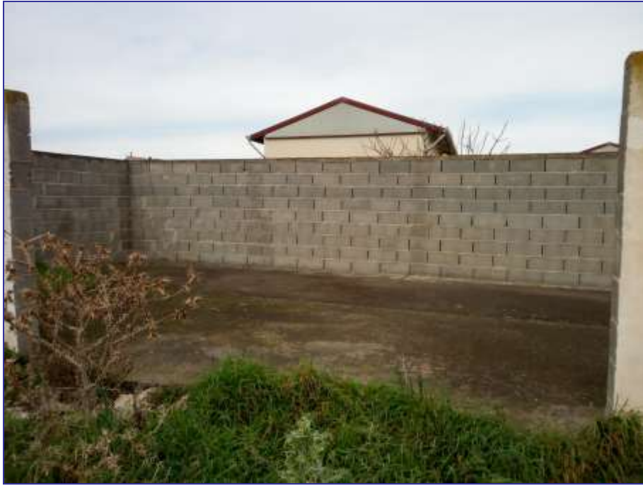
Foto 63 – Concimaia presente nella superficie destinata a corte facente parte della particella 159, in prossimità dei campi seminativi della stessa azienda, nella parte retrostante ai fabbricati.
