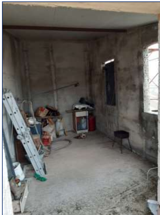
Foto 81 – Imm. 5 – Locale di sgombero al piano primo adiacente all'appartamento privo di autorizzazione.
