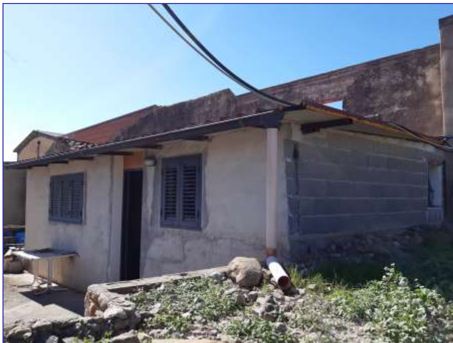
Foto 26 – Imm. 2 – Alloggio custode . Prospetto immobile alloggio custode.
