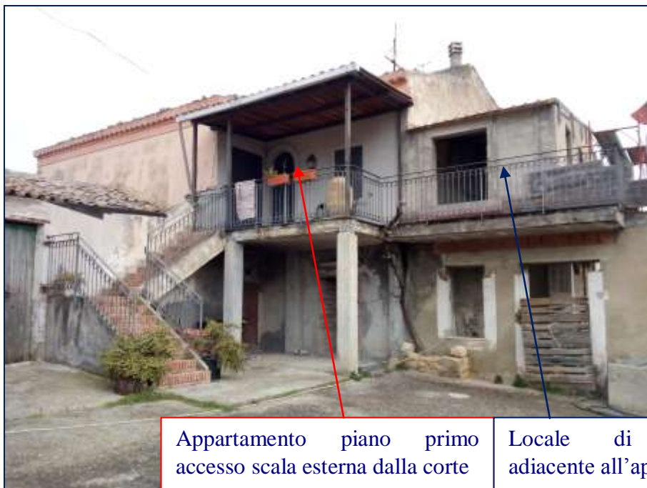
Foto 67 – Imm. 5 – Individuazione dell'appartamento al piano primo con adiacente locale di sgombero, con accesso mediante cortile comune e scala esterna.
