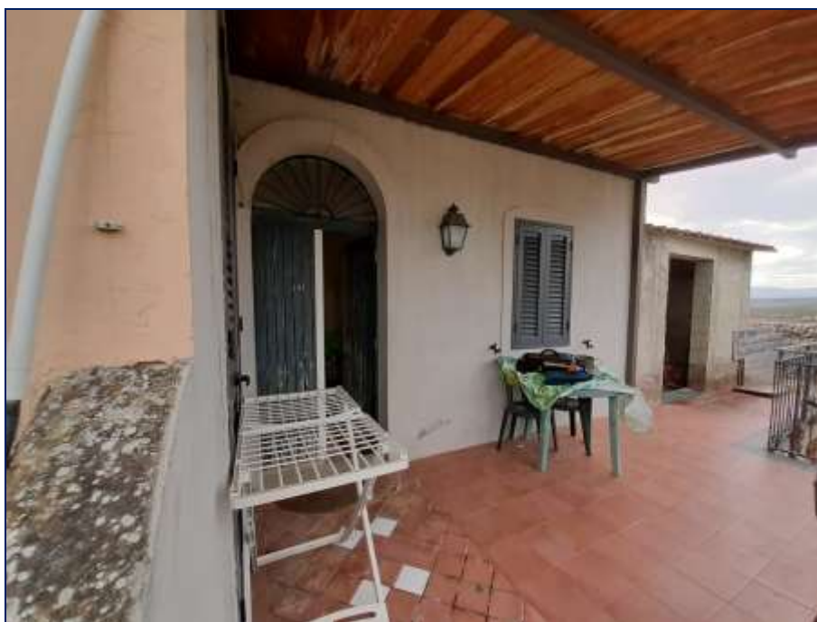
Foto 69 – Imm. 5 – Terrazzo principale di accesso all'appartamento ed al locale di sgombero adiacente.
