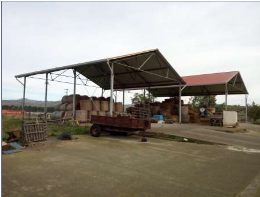
Foto 40 – Imm. 3 – Tettoie . Altra immagine delle tettoie.
