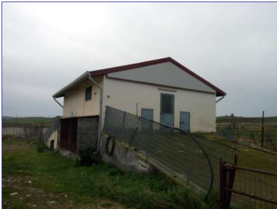
Foto 58 – Imm. 4 – Prospetto Nord – Est corpo sala mungitura.
