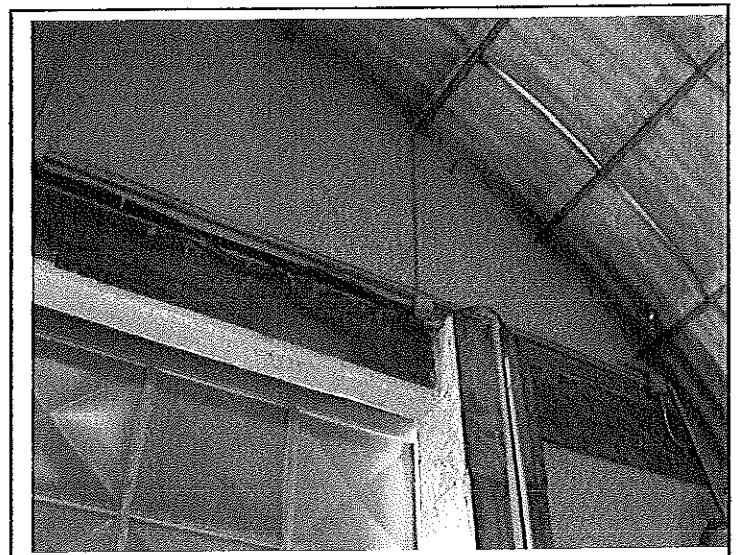
Foto 6 – Particolare vista interna
