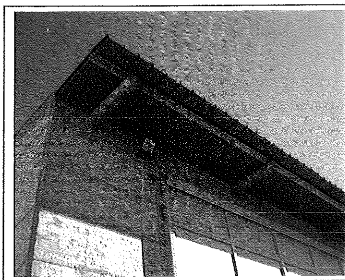
Foto 2 – Particolare della copertura
