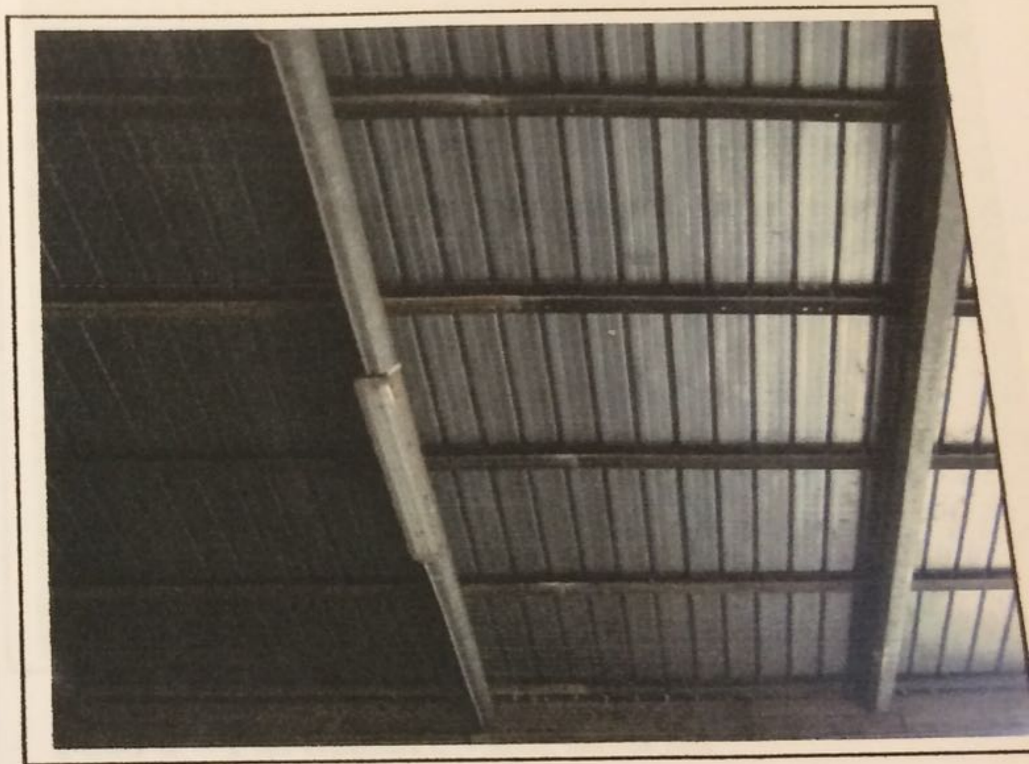
Foto 3 – Vista inter., partic. della copertura
