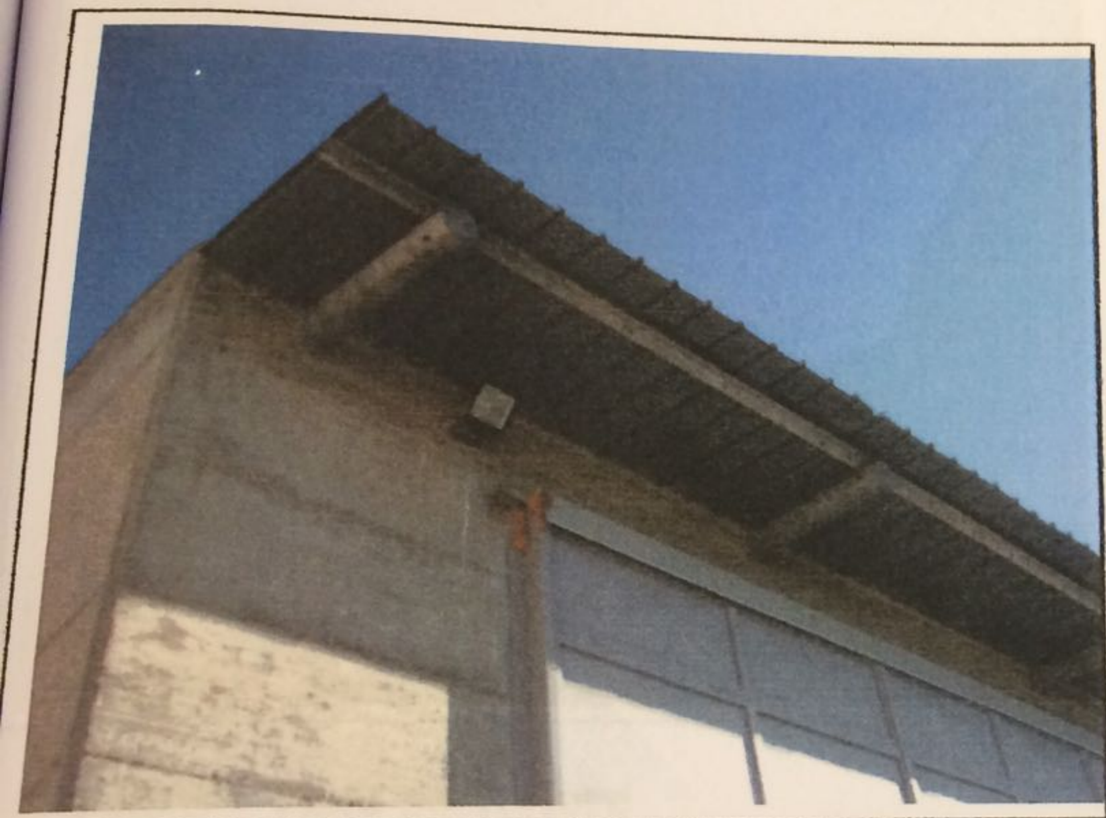
Foto 2 – Particolare della copertura
