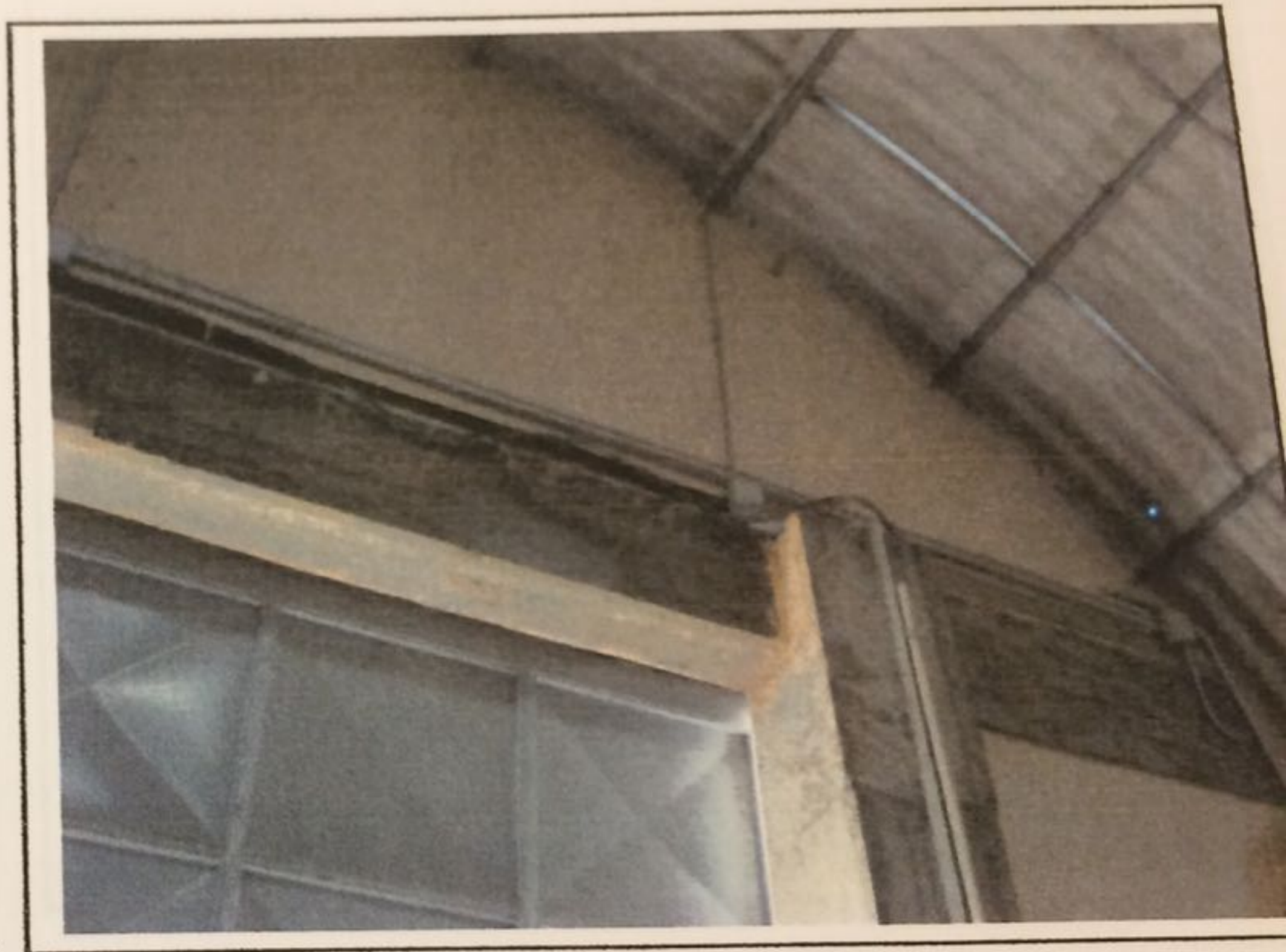
Foto 6 – Particolare vista interna
