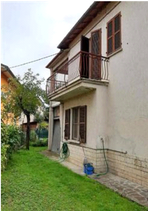
lato sx e scoperto esclusivo del fabbricato
