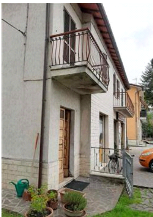
Vista fronte-lato sx
