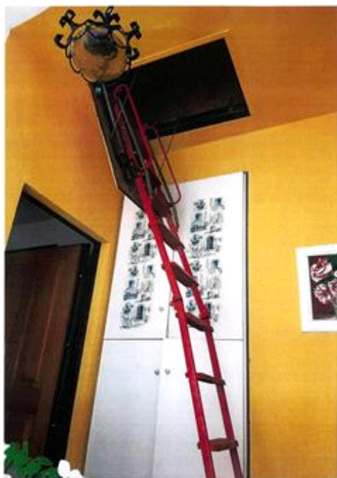
Botola e scala retrattile per accedere alla soffitta Piano 2
