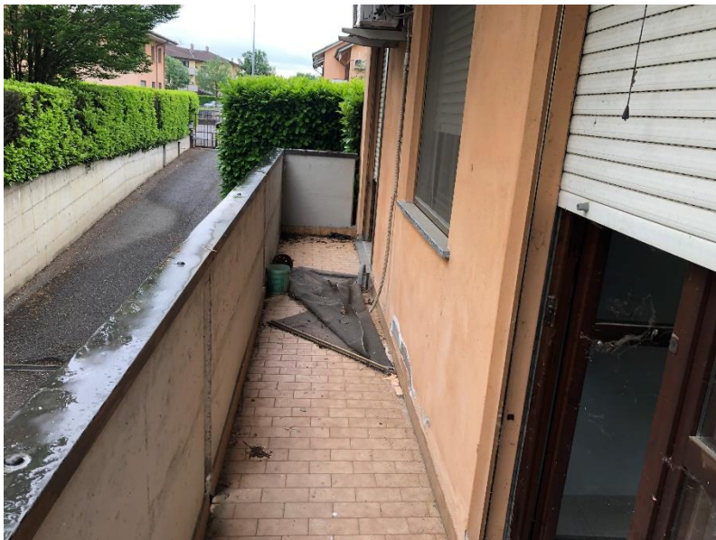
Balcone camere e bagno
