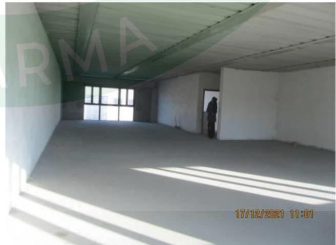
La porta d'ingresso è del tipo blindata, mentre mancano le tramezze interne e tutte le altre finiture (pavimentazione, porte, tinteggi, illuminazione, sanitari, ecc.). Per l'impianto elettrico sono state posate soltanto le tubazioni, mentre manca l'impianto stesso. Le fognature sono ultimate.
