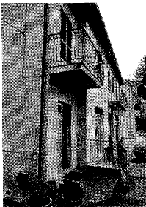
Vista fronte-lato sx
