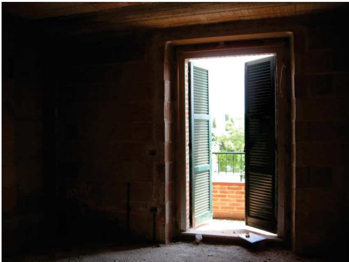
EDIFICIO A SCHIERA “ [REDACTED] ” – STATO GREZZO – PIANO PRIMO
