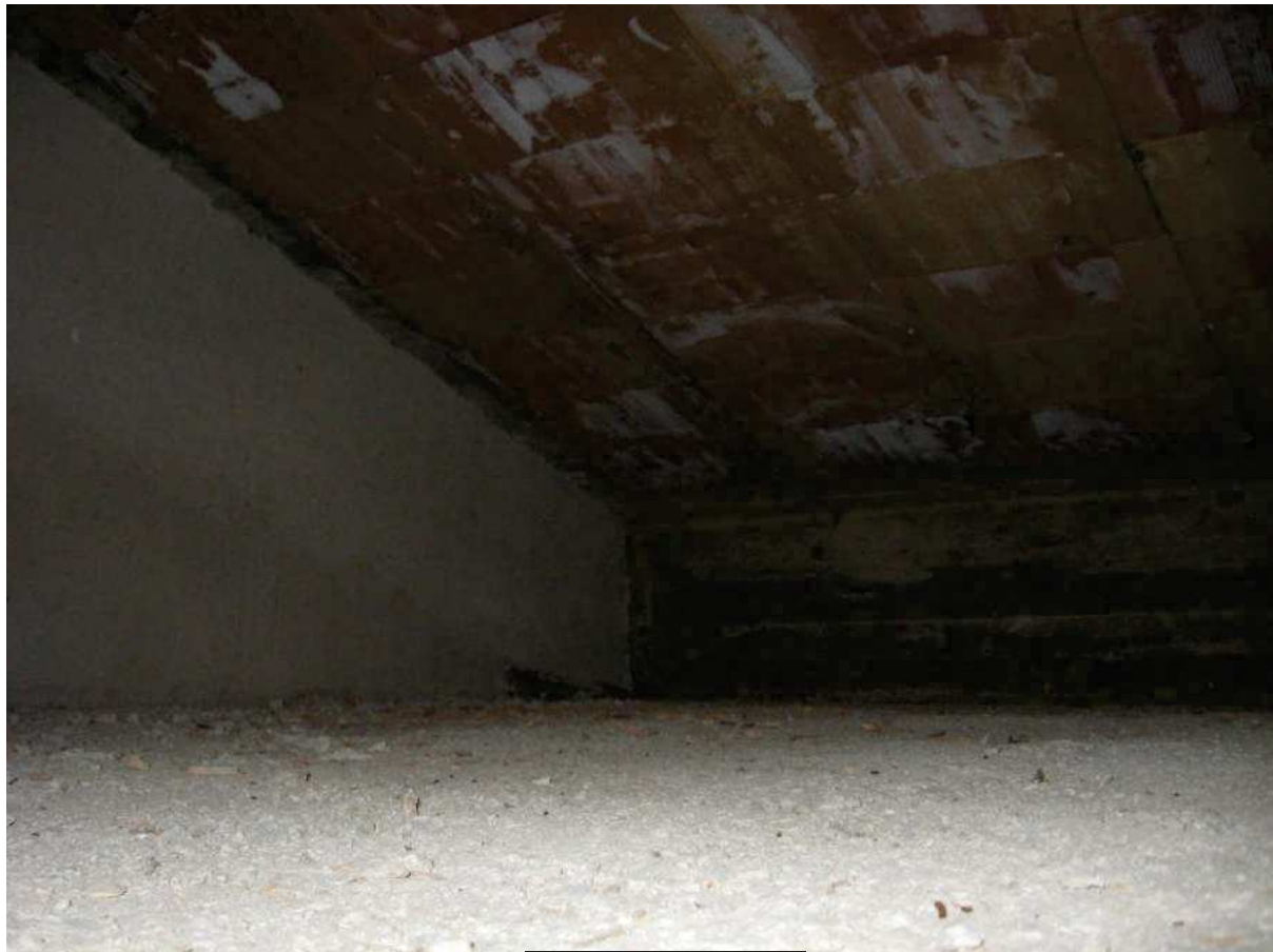
EDIFICIO A SCHIERA “ [REDACTED] ” – STATO GREZZO PIANO SOTTOTETTO
