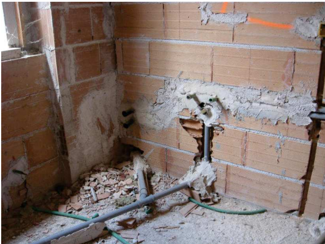
EDIFICIO A SCHIERA “ [REDACTED] ” – STATO GREZZO – PIANO TERRA
