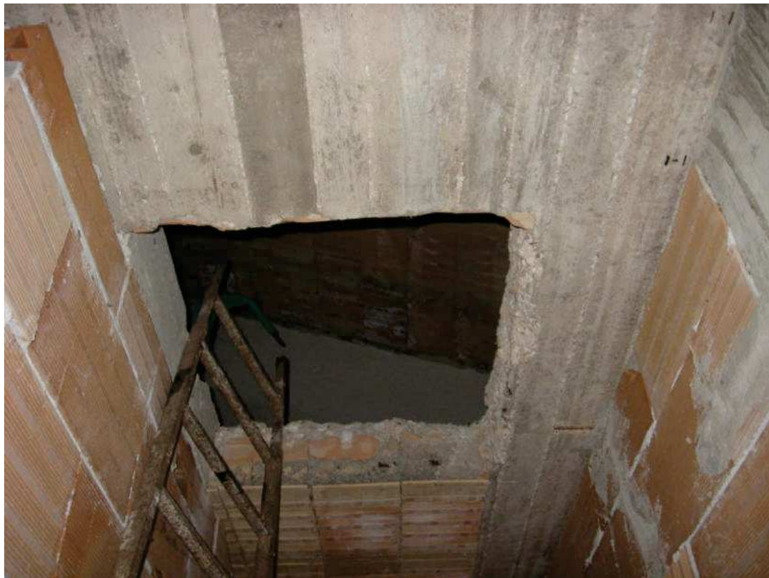
EDIFICIO A SCHIERA “ [REDACTED] L “ – STATO GREZZO – PIANO PRIMO ACCESSO AL SOTTOTETTO
