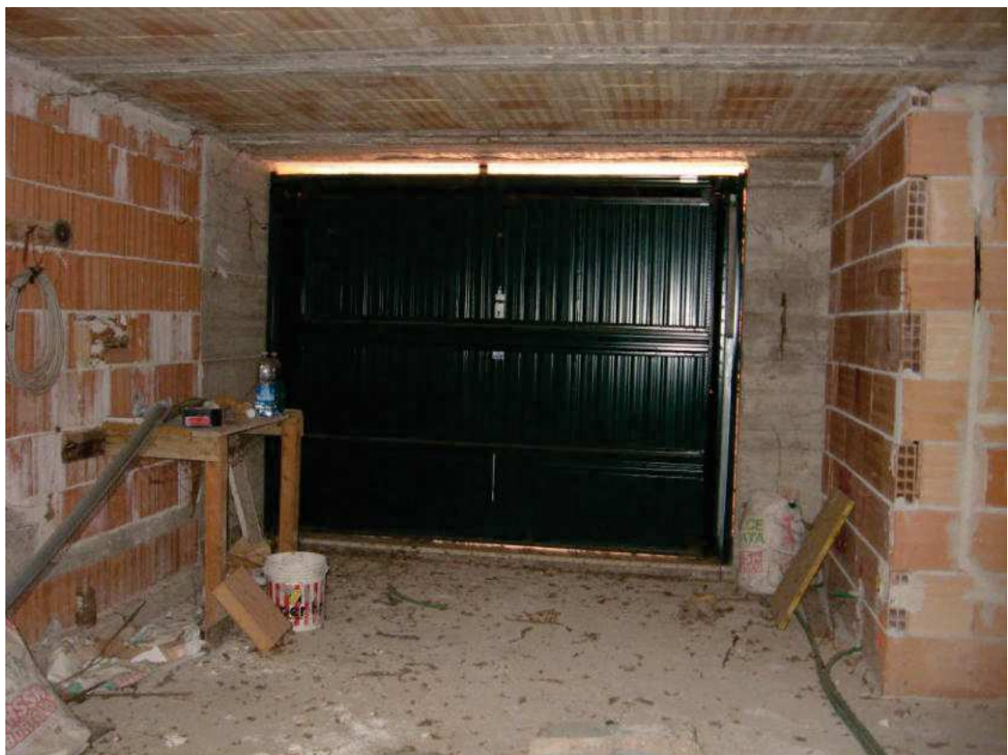
EDIFICIO A SCHIERA “ [REDACTED] ” – STATO GREZZO PIANO SEMINTERRATO
