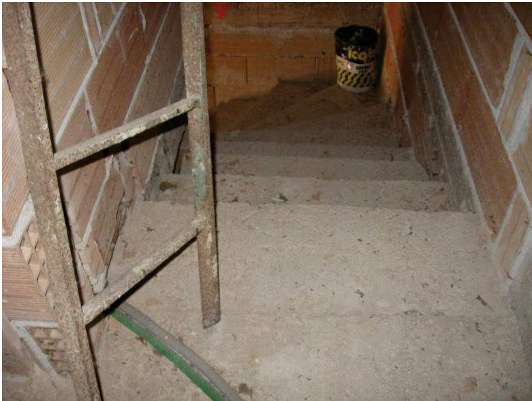
EDIFICIO A SCHIERA “ [REDACTED] L “ – STATO GREZZO SCALA INTERNA
