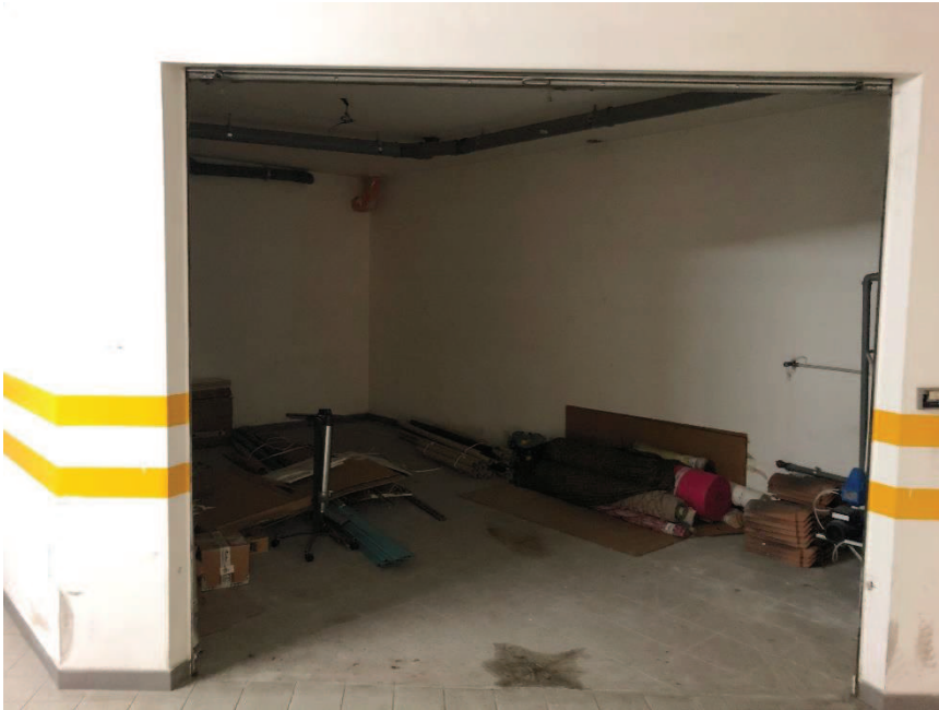
Foto n. 5: Ingresso locale deposito
