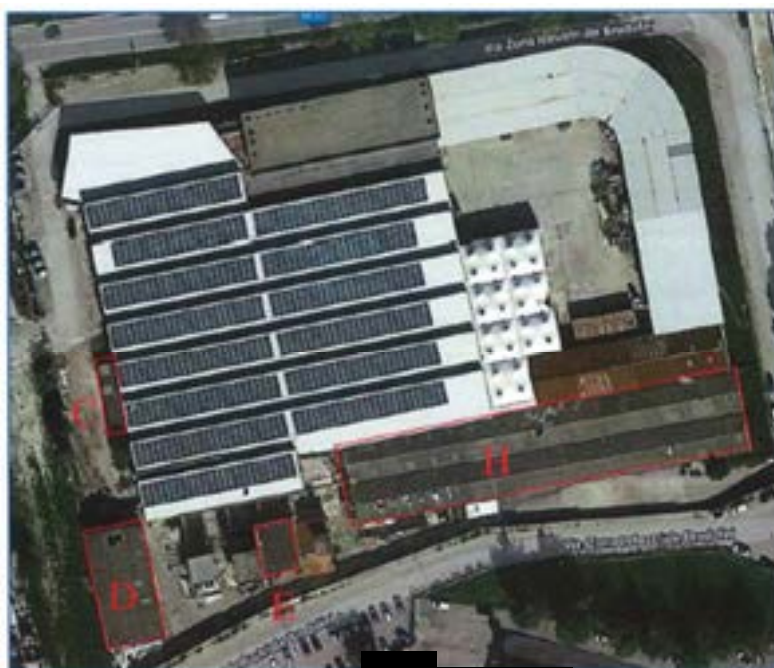
Foto coperture in materiali contenenti amianto - fonti [REDACTED]
