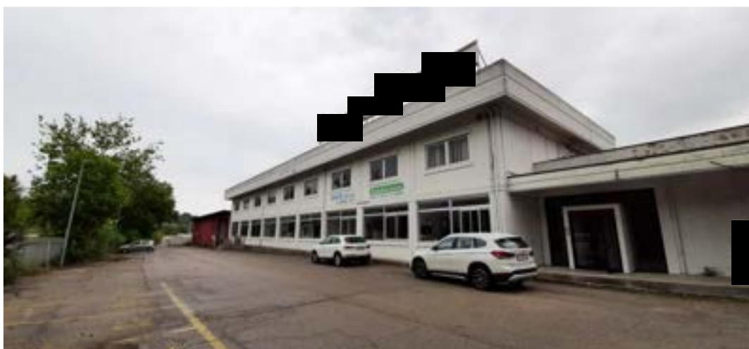
Foto – Porzione del fronte su Strada Provinciale 77 della Val di Chienti
