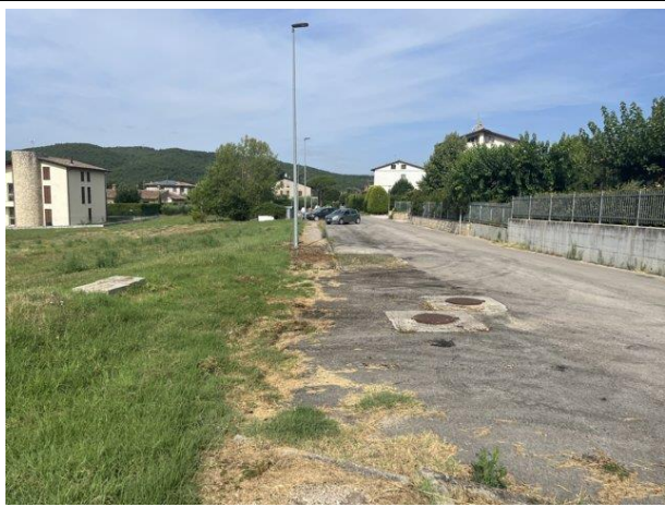
Documentazione fotografica - Vista n.2
