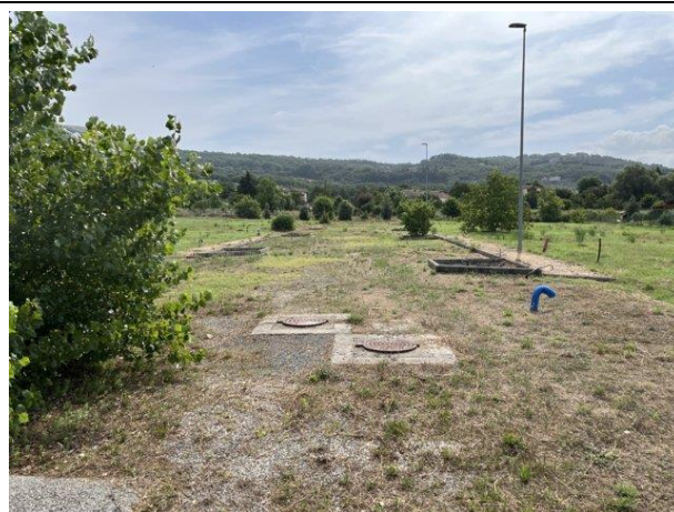
Documentazione fotografica - Vista n.7
