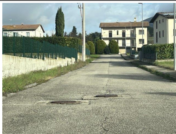
Documentazione fotografica - Vista n.9
