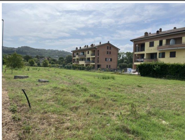
Documentazione fotografica - Vista n.8
