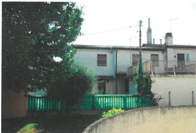
Il prospetto ovest dell'appartamento dalla proprietà contermina
