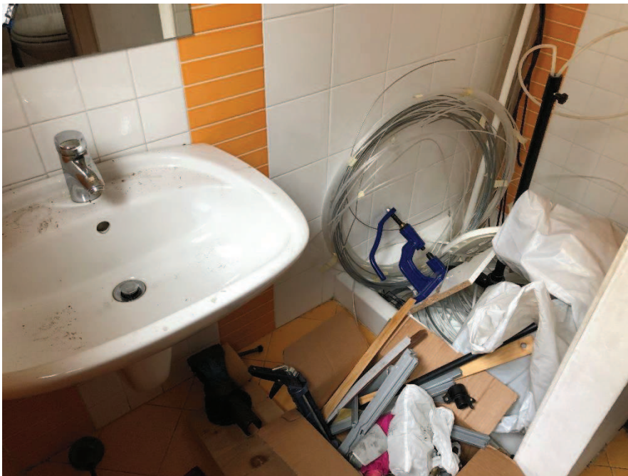
Foto n. 14: W.C. Spogliatoio n. 2
