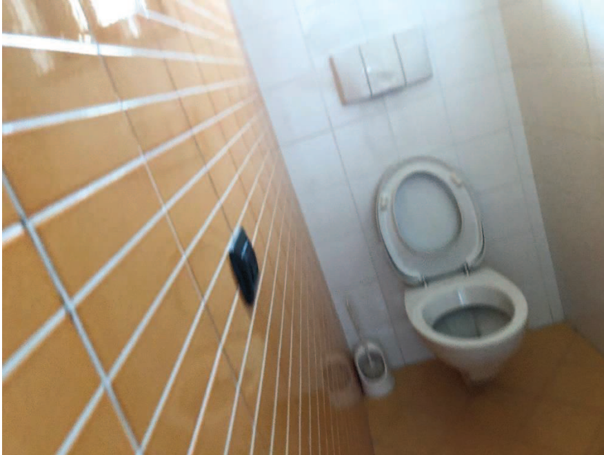
Foto n. 17: W.C. Spogliatoio n. 1
