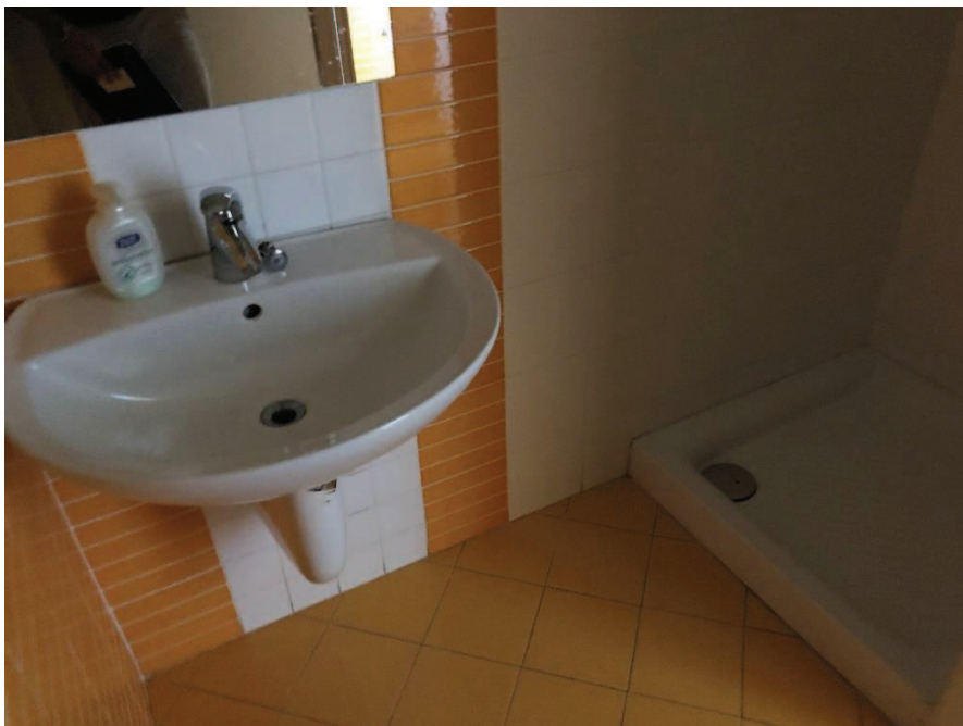
Foto n. 18: W.C. Spogliatoio n. 1
