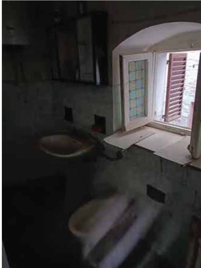
FOTO 5 – Vista del bagno
