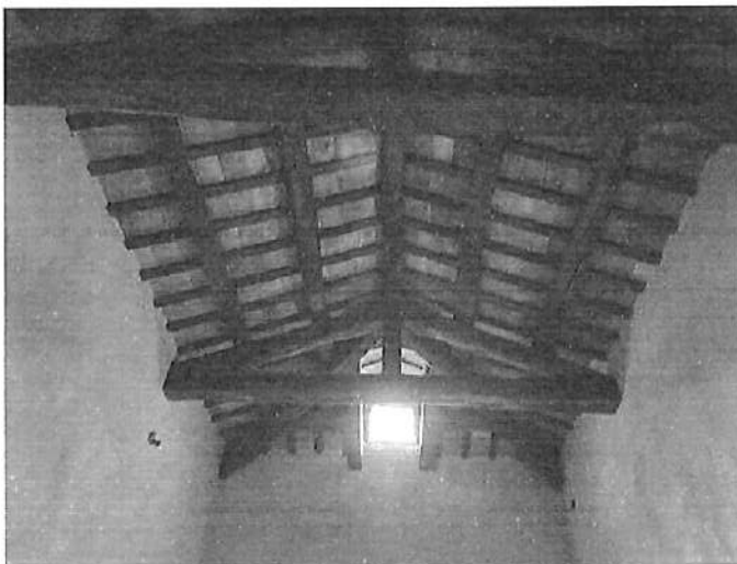
foto n. 39 – copertura nel soppalco – P3
