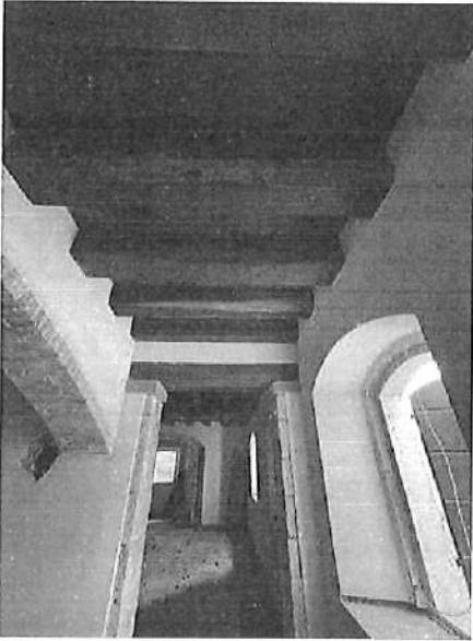
foto n. 19 – piano terra verso disimpegno
