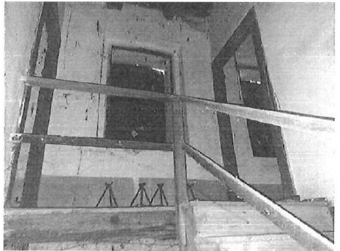
foto n. 58 – pianerottolo al P1
