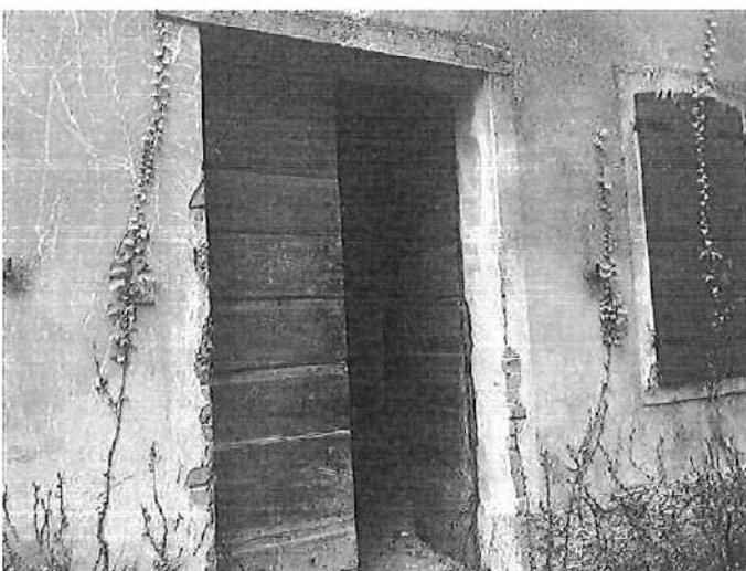
foto n. 53 – ingresso alla parte abitativa
