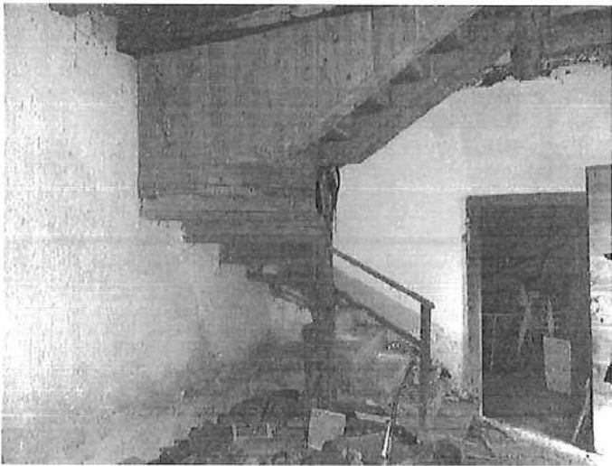
foto n. 57 – scala di accesso al P1
