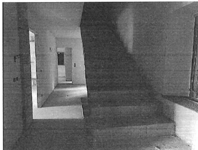
foto n. 28 – disimpegno al P1 e scala di accesso al P2
