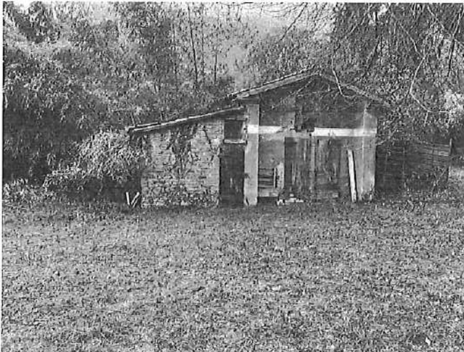
foto n. 67 – ex porcile-pollaio - prospetto est
