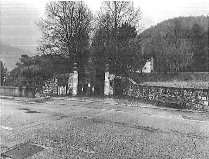
foto n. 1 – accesso al lotto da via degli Alpini
