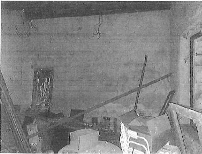
foto n. 55 – piano terra - locale cucina
