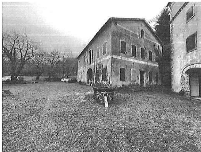
foto n. 50 – prospetto sud e parte area perlinenziale
