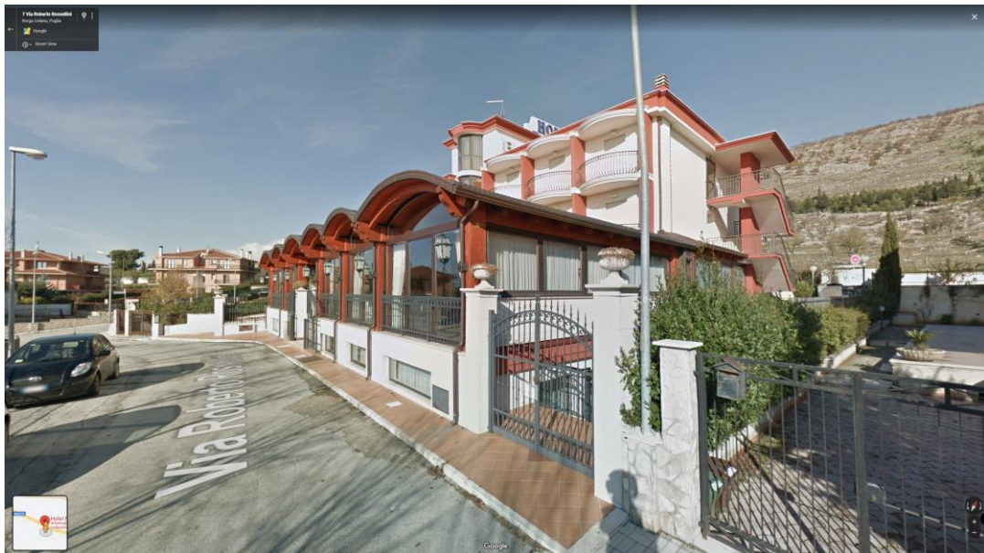
Figura 5: Complesso Hotel Ristorante – prospetto Via Roberto Rossellini, 2
