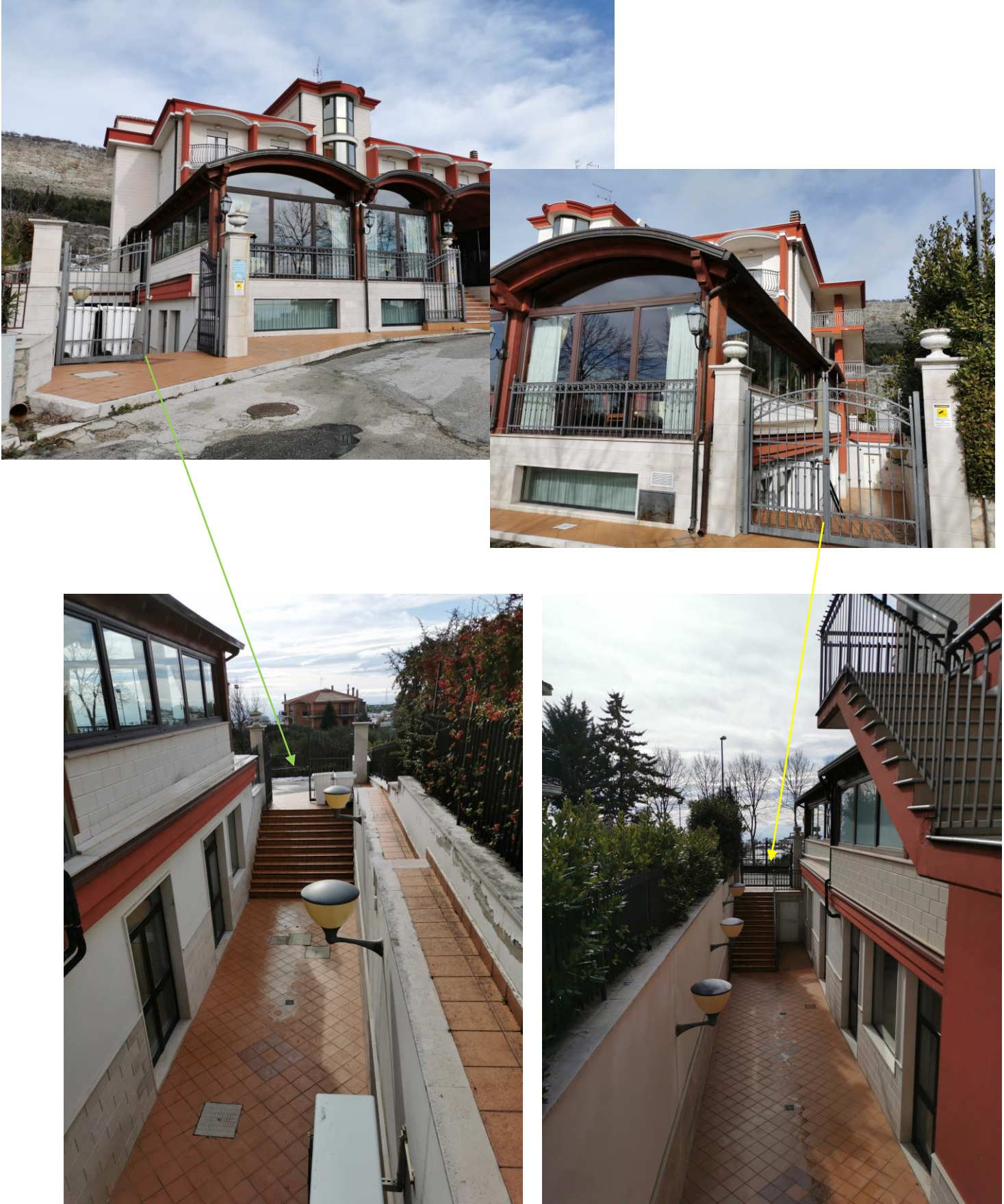
Figura 6: Complesso Hotel Ristorante – prospetto Via Roberto Rossellini, 2
