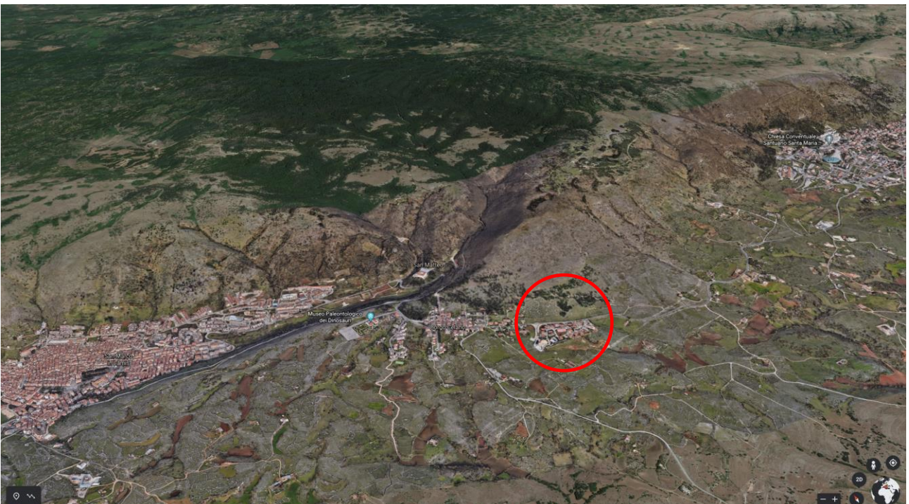
Figura 2: Complesso Hotel Ristorante - Via Roberto Rossellini, 2, 71014 Borgo Celano FG (41.702307, 15.661743)
