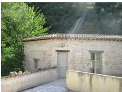
fabbricato finito al P.1
