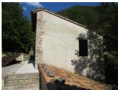
vista del magazzino allo stato grezzo del P.1
