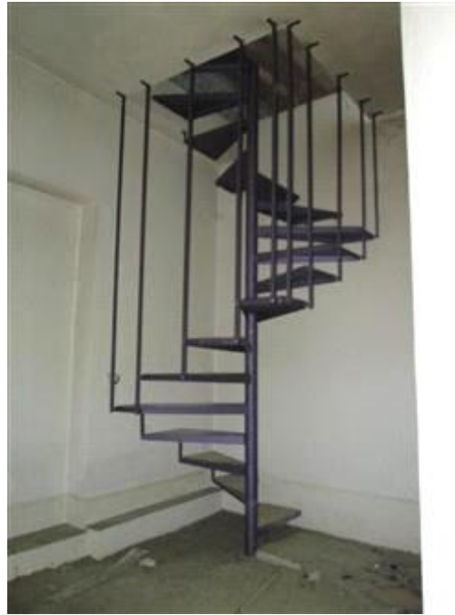
Scala interna di collegamento tra P.T. e P.1 a chiocciola
