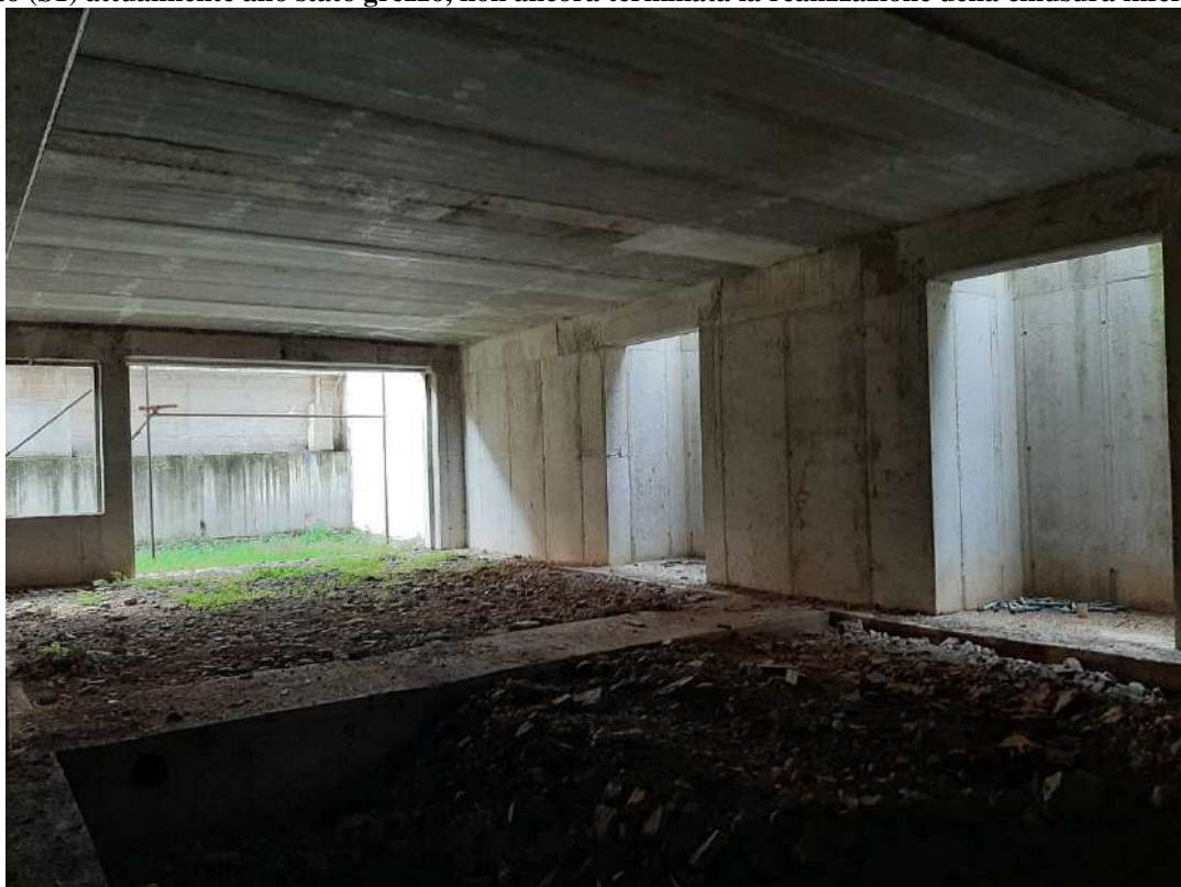
Foto n. 6. Vista interno unità immobiliare A (Lotto n. 1), Comune di Gubbio, Foglio n. 196, Part. n. 7011 Sub 2, piano interrato (S1) attualmente allo stato grezzo, non ancora terminata la realizzazione della chiusura inferiore
