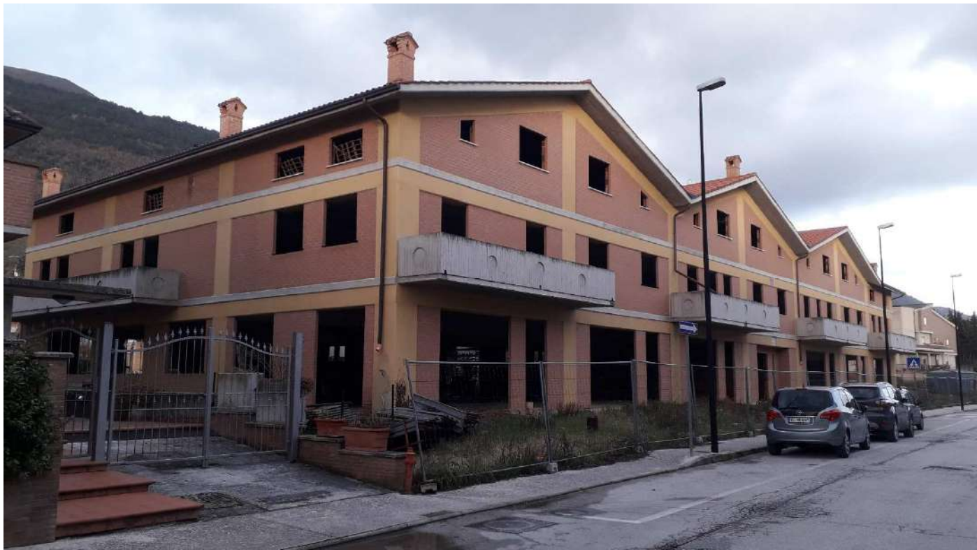
Foto n. 1. Vista esterno unità immobiliare A (Lotto n. 1), Comune di Gubbio, Foglio n. 196, Part. n. 7011 Sub 2 (Fabbricato ad uso artigianale – Unità in corso di costruzione) e area pertinenziale (Foglio n. 196, Part. n. 7011). Vista sud-ovest
