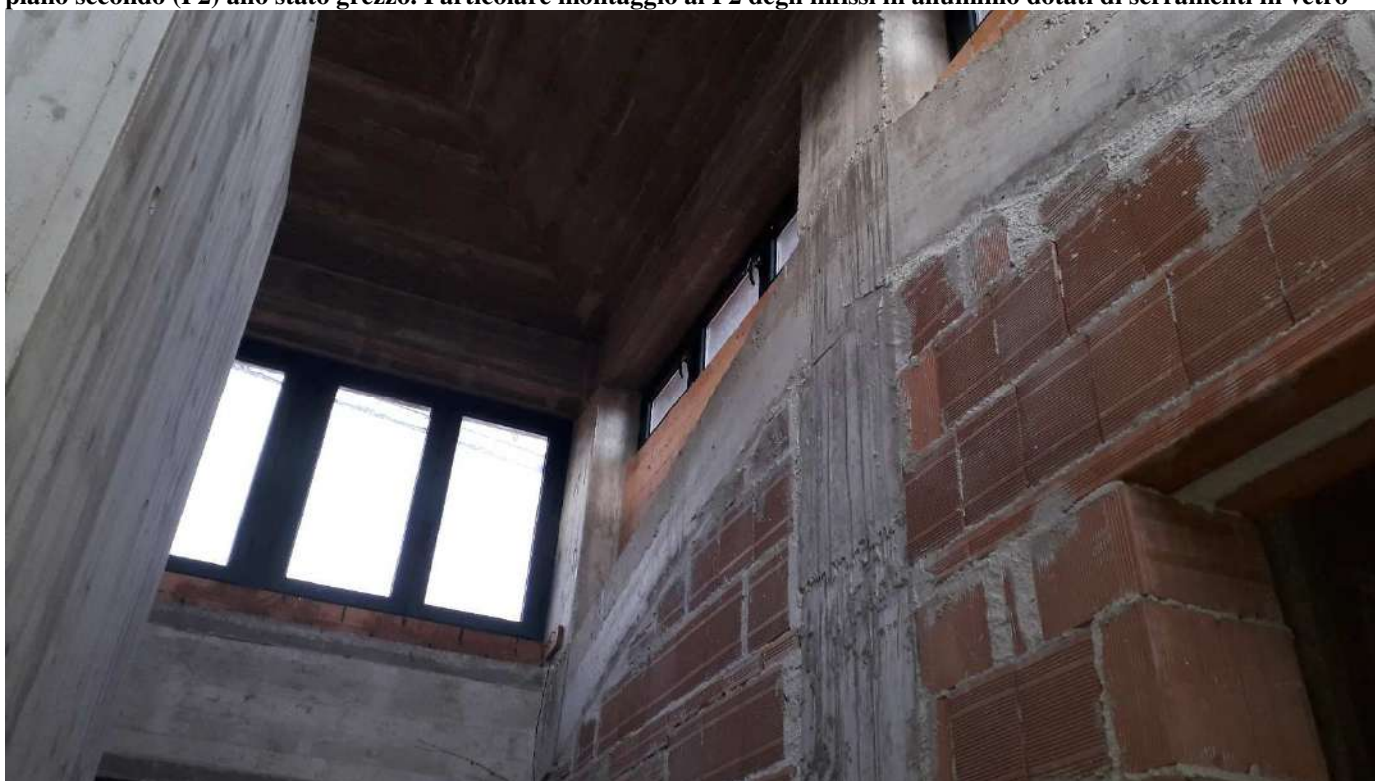
Foto n. 20. Vista interno unità immobiliare A (Lotto n. 1), Comune di Gubbio, Foglio n. 196, Part. n. 7011 Sub 2, piano secondo (P2) allo stato grezzo. Particolare montaggio al P2 degli infissi in alluminio dotati di serramenti in vetro
