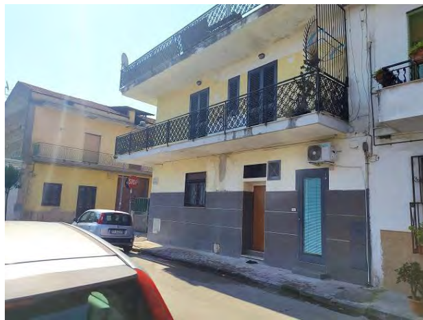
Vista da Via Garibaldi
