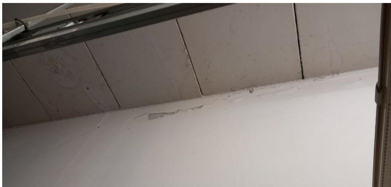
INFILTRAZIONI UMIDITÀ - SOFFITTO DEL LABORATORIO
