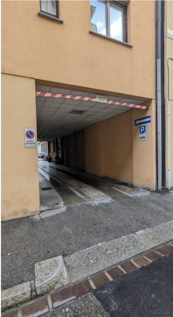
Foto n. 18 – Ingresso garage su via Strozzi
