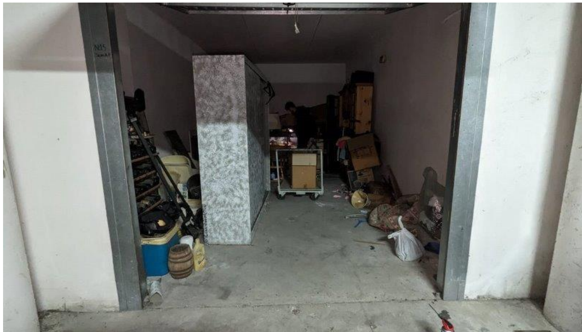
Foto n. 20-21 – Box auto piano interrato
