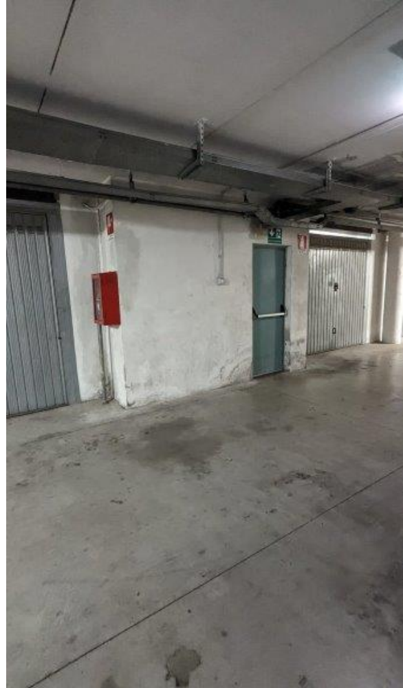
Foto n. 19 – Ingresso box auto dal vano scala F
