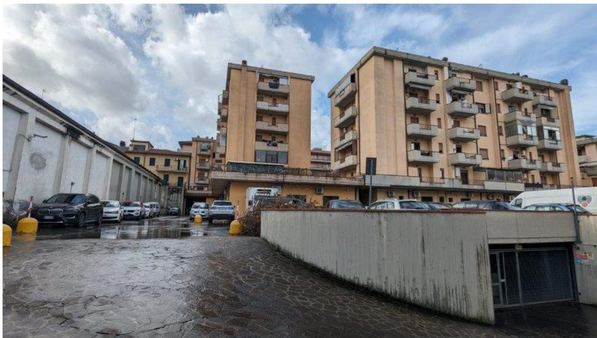
Foto n.17 – Rampa di accesso ai box auto condominiali collocata sul retro del fabbricato
