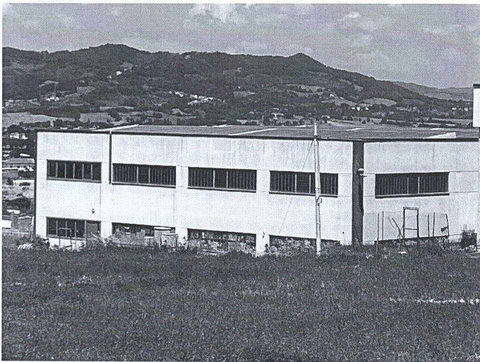
Impianto fotovoltaico sulla copertura del laboratorio artigianale
