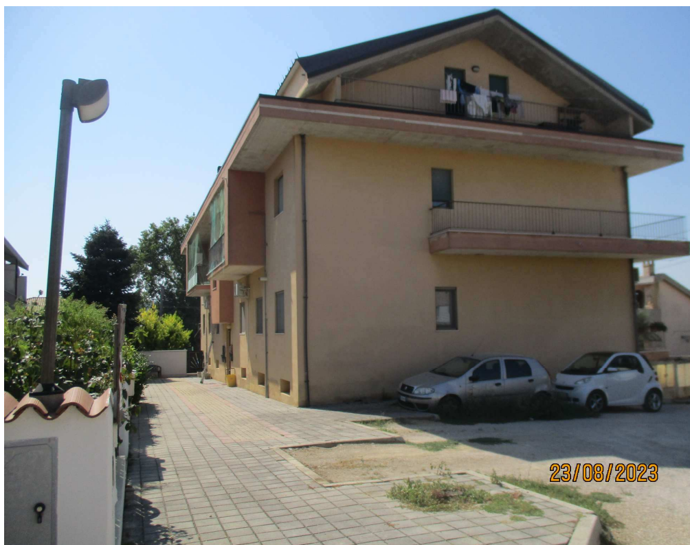
Foto n° 1: Vista del fabbricato
