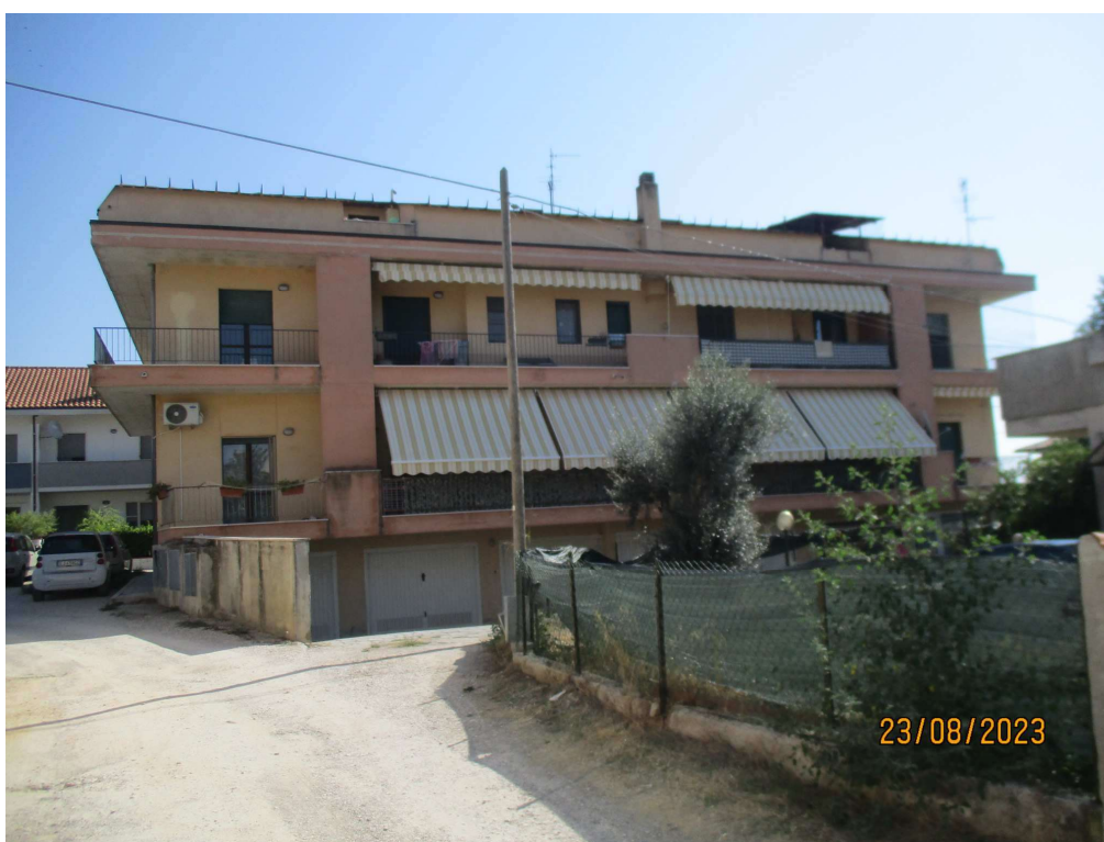
Foto n° 2: Altra vista del fabbricato
