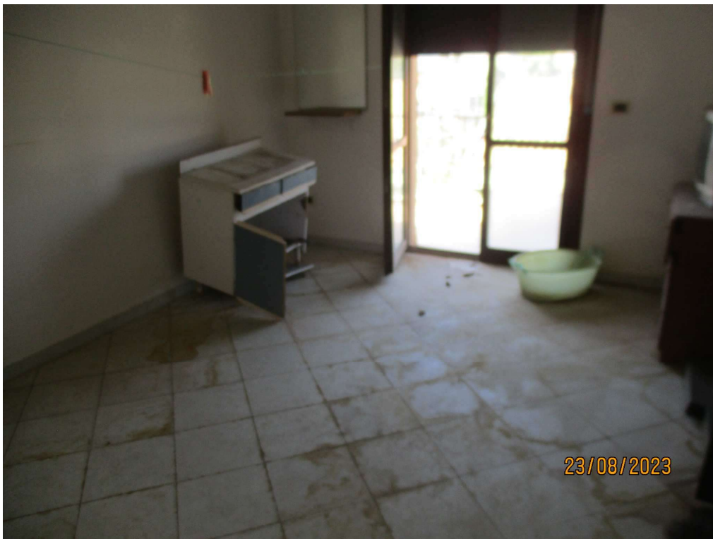
Foto n° 8: Vista altra camera
