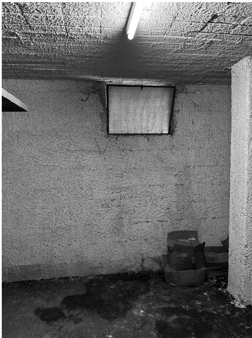
FOTO 10. DETTAGLIO INTERNO BOX (FINESTRONE LUCE).
