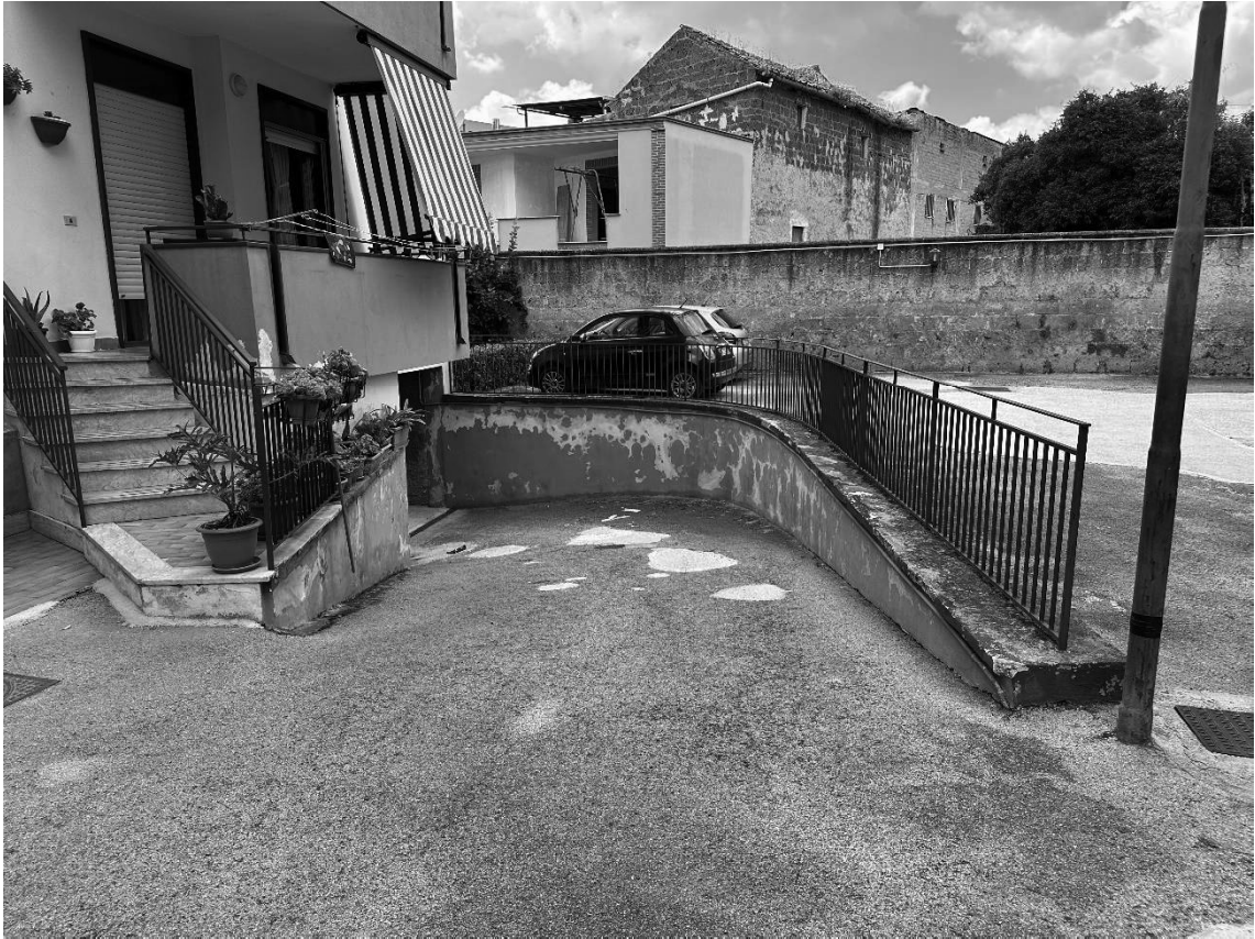
FOTO 5. RAMPA DI DISCESA AL PIANO S1 DELLA SCALA/EDIFICIO A.
