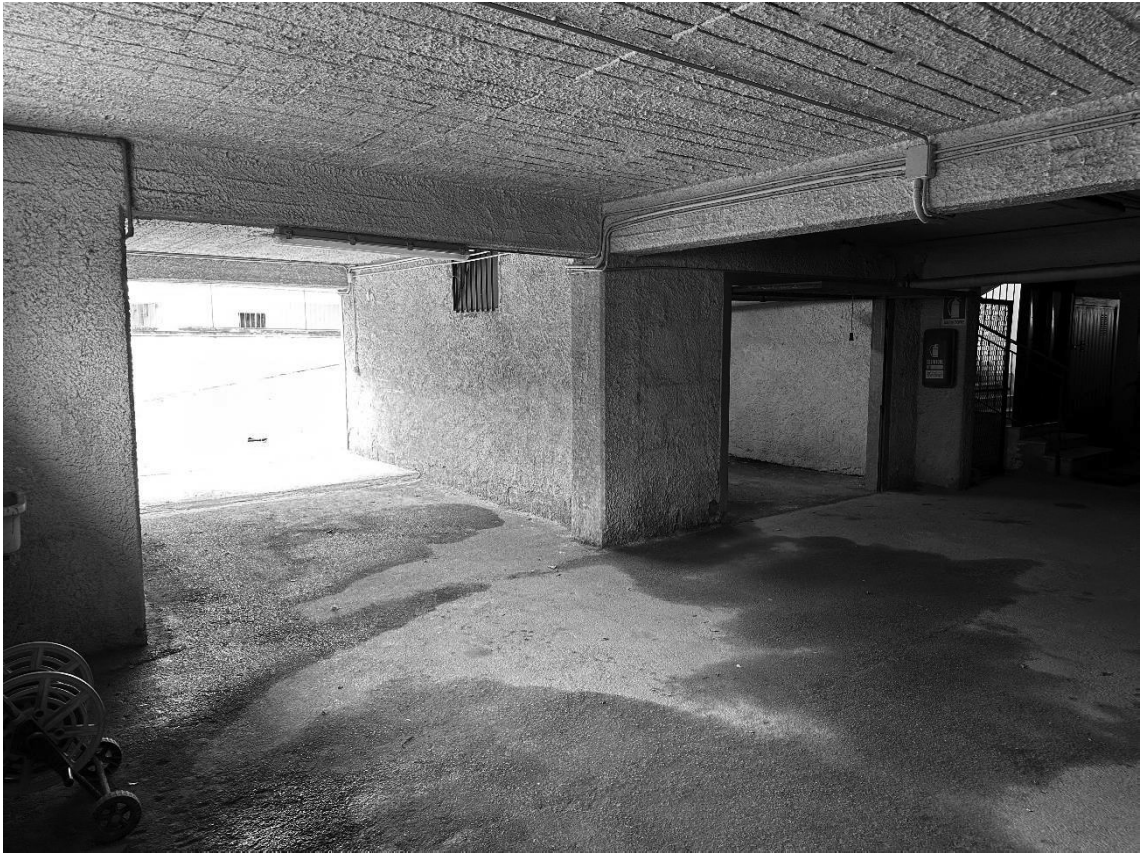
FOTO 7. DETTAGLIO RAMPA DISCESA AL PIANO S1 E INGRESSO BOX [1].
