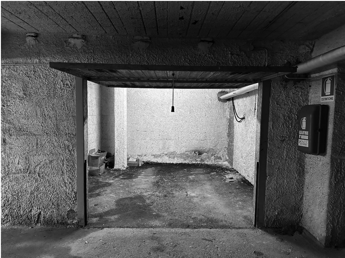
FOTO 8. INGRESSO BOX DI PROPRIETA' DELLA LOGICA COSTRUZIONI SRL.
