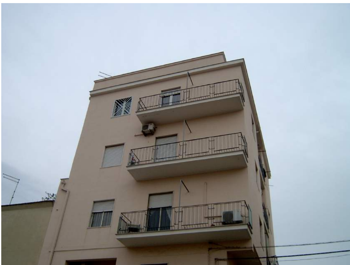
Foto n. 1 – Prospetto del fabbricato su Piazza P. Bona
