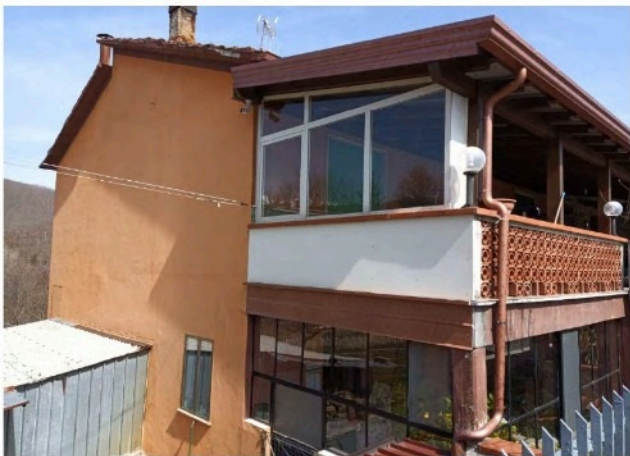
foto n° 2 - Vista Esterna Immobile Bene 1
