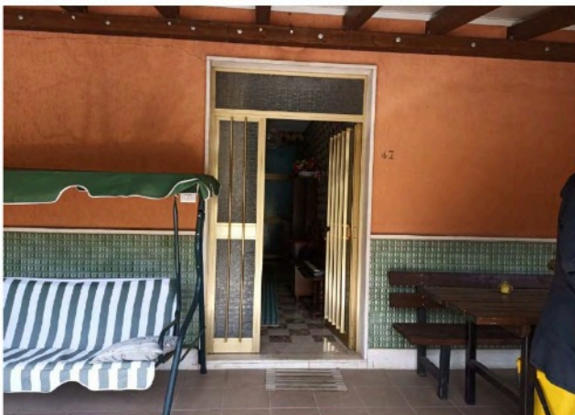
foto n° 3 - Vista Esterna Immobile Bene 1
