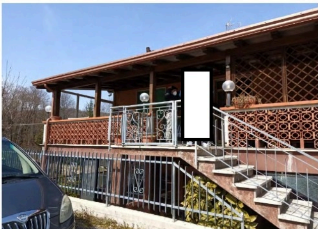
foto n° 1 - Vista Esterna Immobile Bene 1
