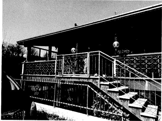
l'immobile si presentava in discreto stato di manutenzione e conservazione considerando la data di realizzazione antecedente presumibilmente al 1967 e con caratteristiche sia per tipologia che per scelta dei materiali adoperati risalenti a quell'epoca. La struttura portante è in muratura con solai in latero cementizio. Gli impianti, sia elettrico che idraulico, si presentano in discreto stato e comunque tutti funzionanti. La pavimentazione interna è in graniglia di marmo in buono
