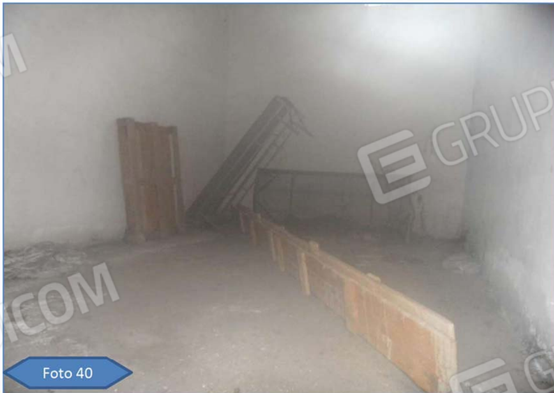
Lotto 2 – Vista particolare del lotto 2.
