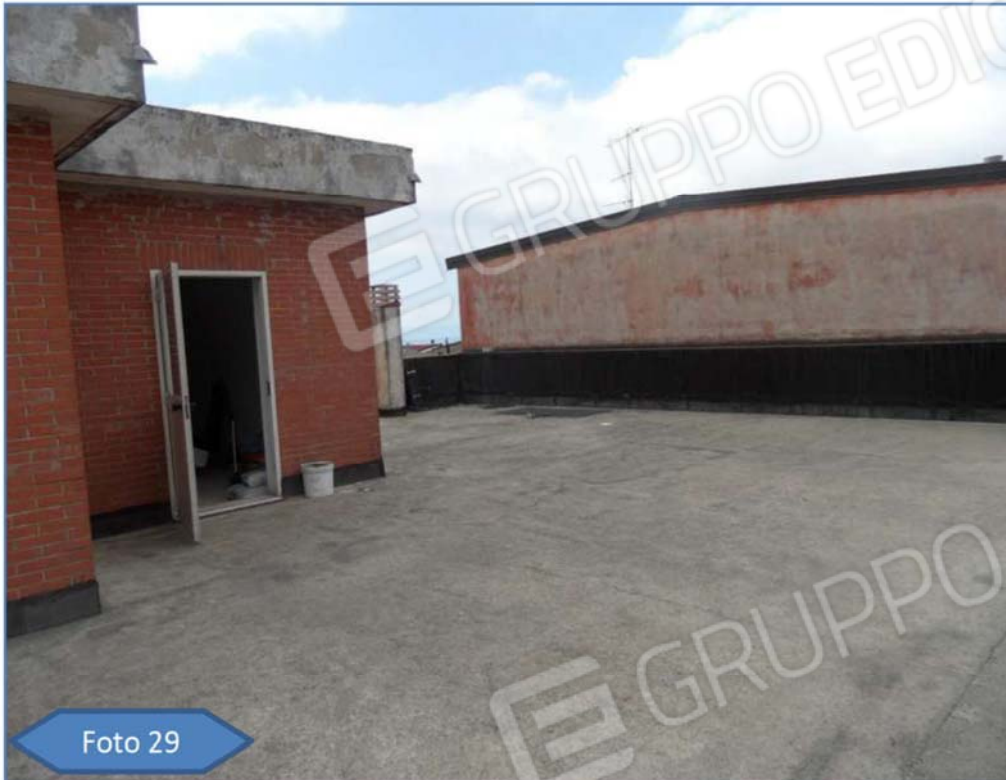
Lotto 1 – Lastrico solare.
