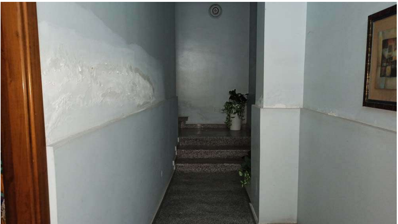
Ingresso vano scala
