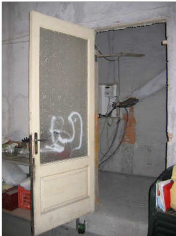
Foto n° 12 – Foto scattata dall'interno del garage alla porta di accesso al vano scala. Attualmente l'accesso alle abitazioni avviene dal garage ed attraverso la porta che collega il vano garage col vano scala.
