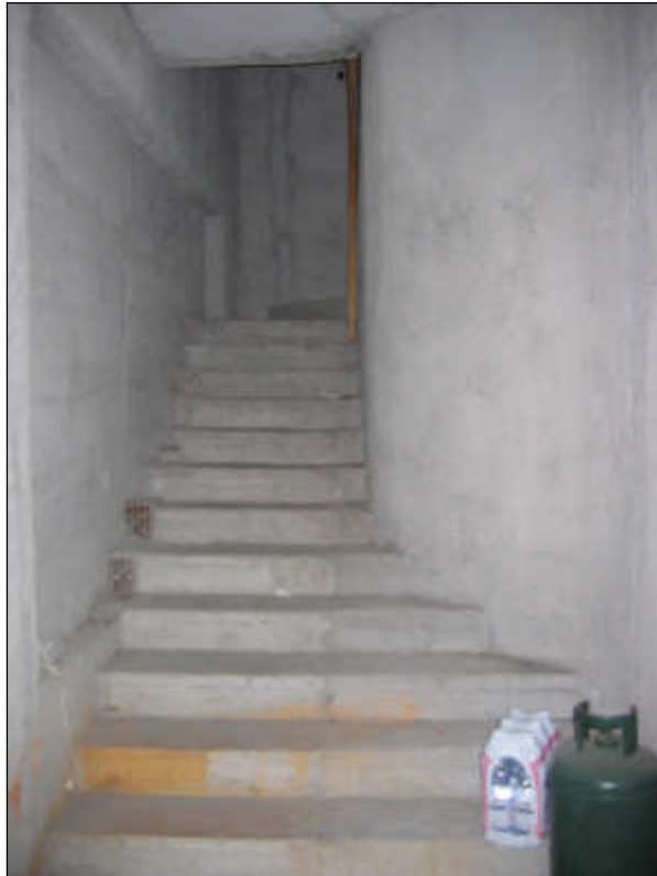
Foto n° 13 – Foto scattata alla scala di accesso ai piani superiori.
