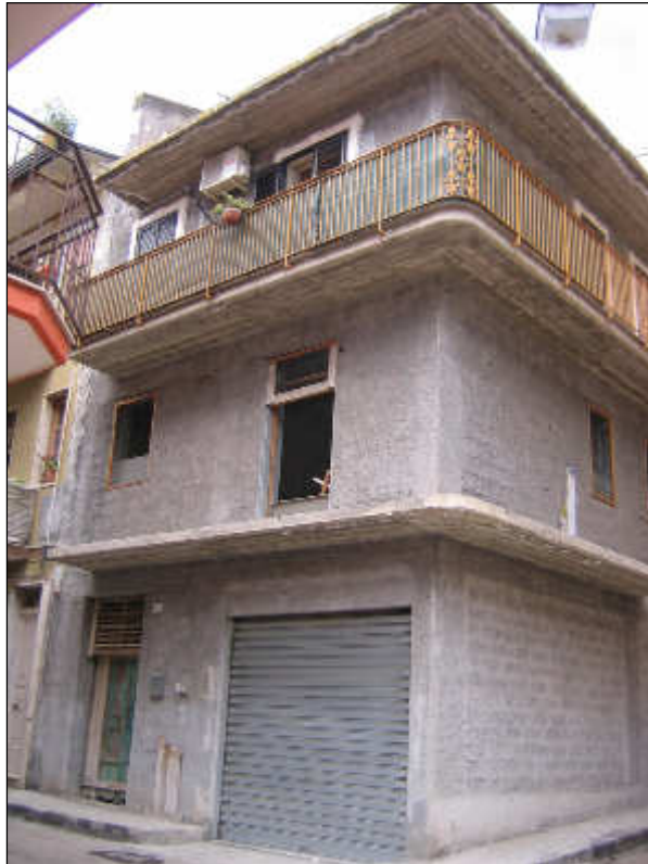
Foto n° 1 – Prospetto edificio di via Toselli, angolo via Dabormida a Scordia.
