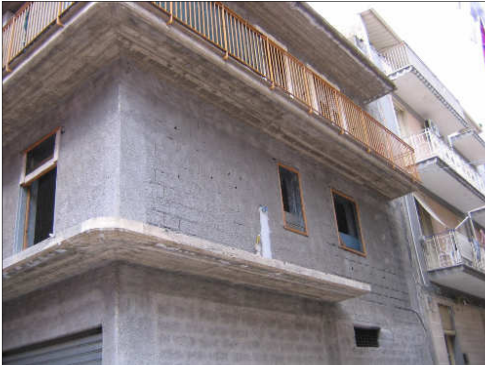
Foto n° 3 – Altra vista dell'edificio situato in via Dabormida a Scordia. Il piano terra ed il primo sono allo stato rustico, ossia è privi di intonaco, di finiture, di infissi e di ringhiere nel ballatoio.
