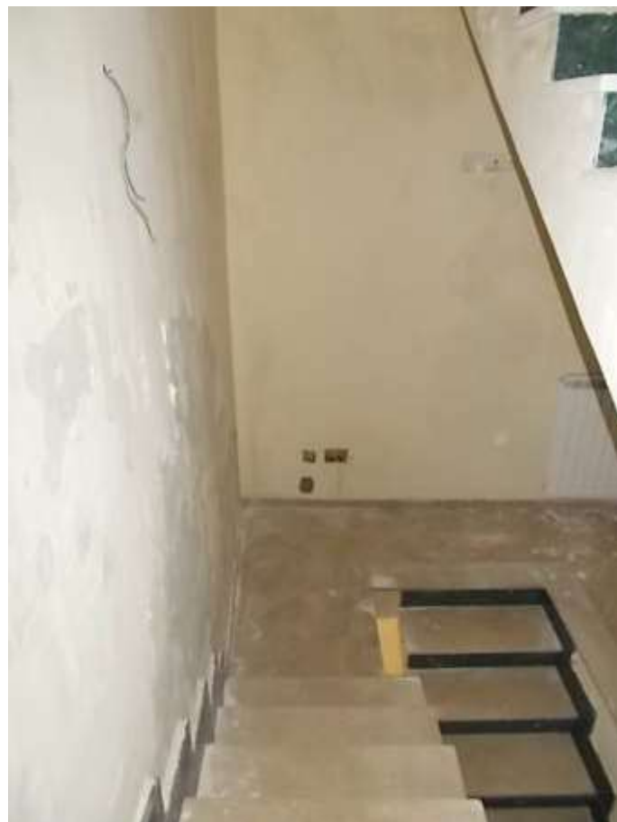
viste della scala con le infiltrazioni provenienti dal muro di sostegno della strada
