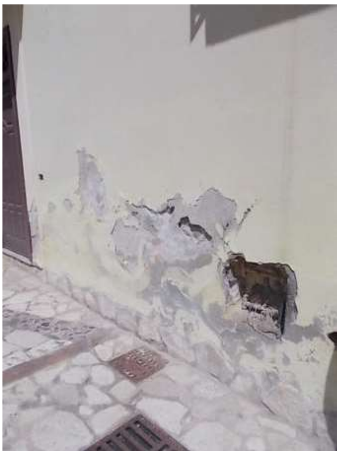
viste esterna ed interna dell'alloggio zona ingresso, si rilevano diffuse chiazze di umidità ascendente e di muffe sui soffitti
