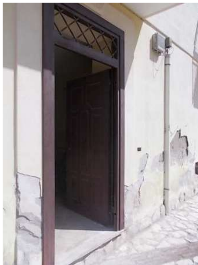
viste esterna ed interna dell'alloggio zona ingresso, si rilevano diffuse chiazze di umidità ascendente e di muffe sui soffitti
