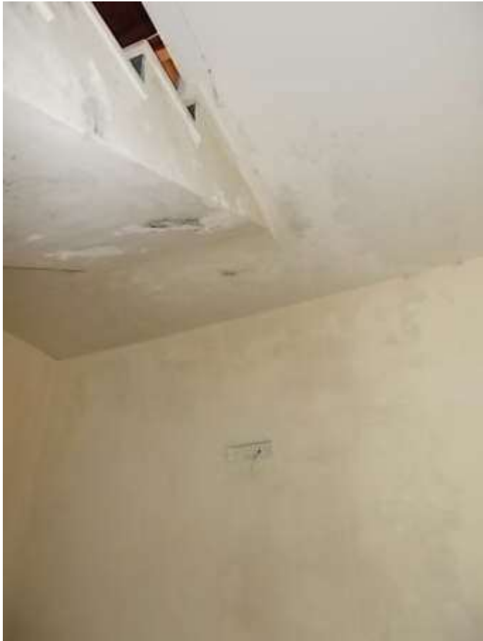
scala all'ultimo piano compromessa dalle infiltrazioni provenienti dal muro di contenimento della strada
