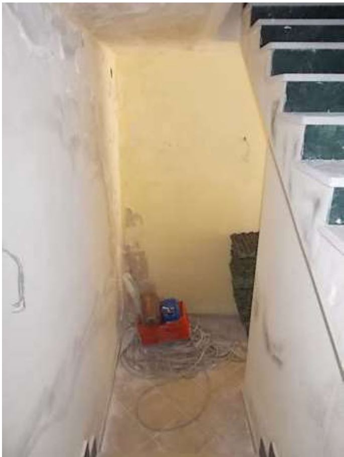
infiltrazioni al piano terra nella zona della scala provenienti dal muro di contenimento della strada
