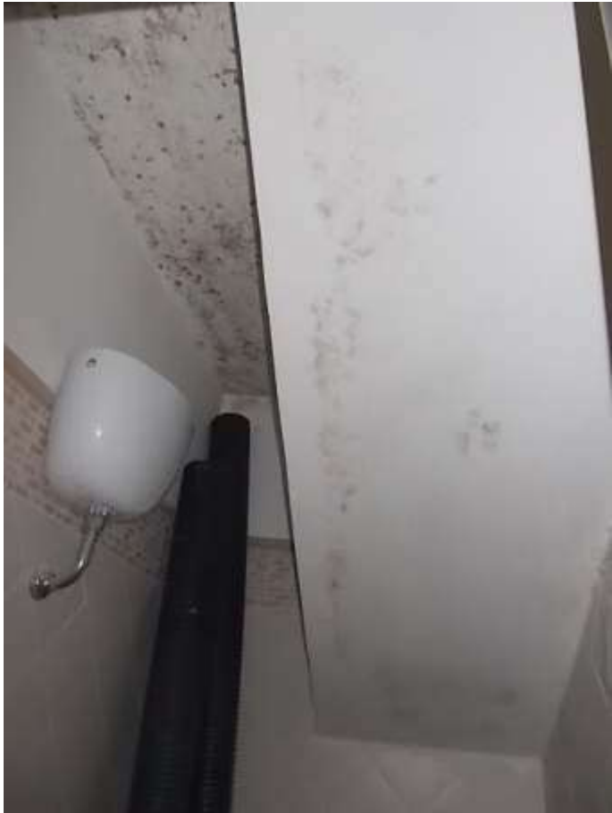
bagno e disimpegno al piano terra invasi da infiltrazioni e muffe
