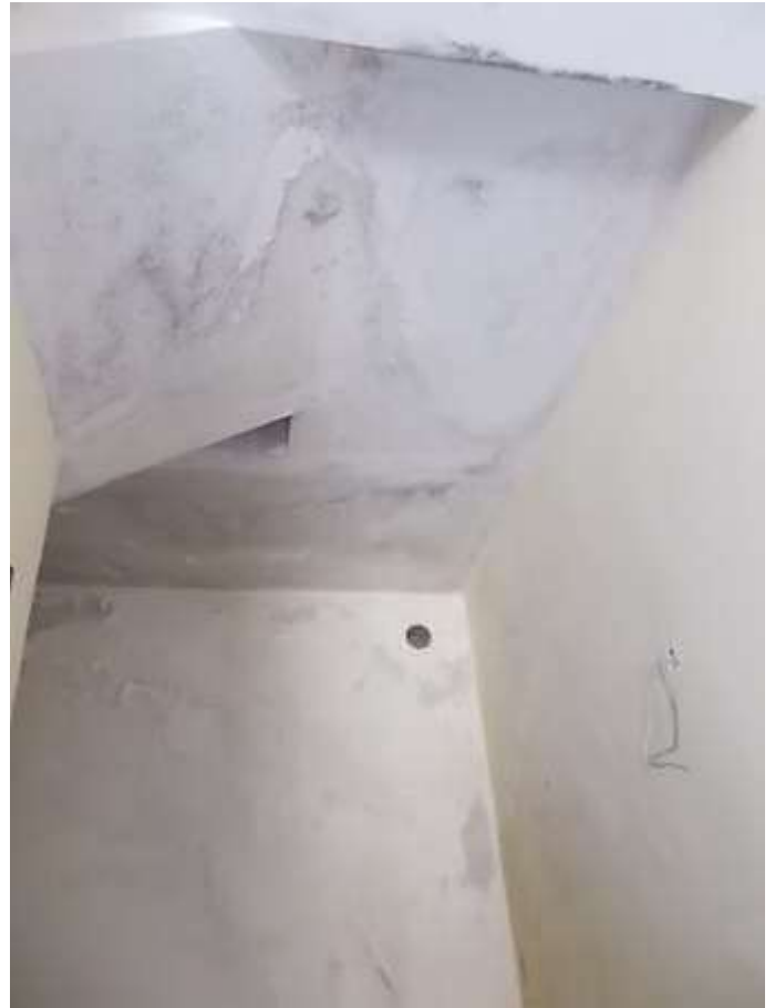
bagno e disimpegno al piano terra invasi da infiltrazioni e muffe
