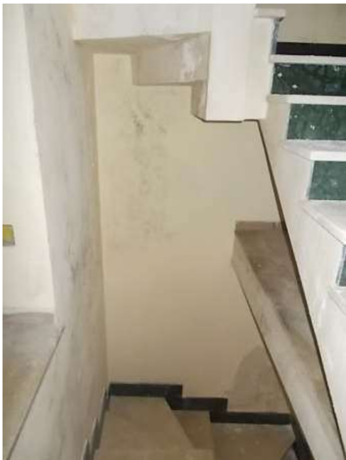
viste della scala con le infiltrazioni provenienti dal muro di sostegno della strada
