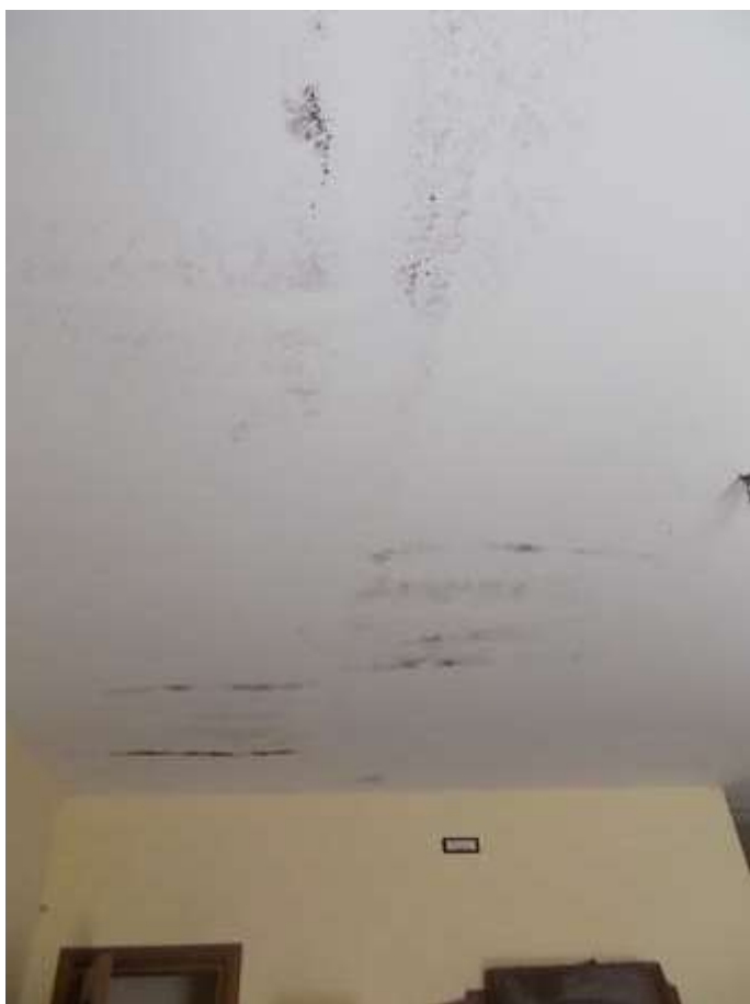
viste esterna ed interna dell'alloggio zona ingresso, si rilevano diffuse chiazze di umidità ascendente e di muffe sui soffitti
