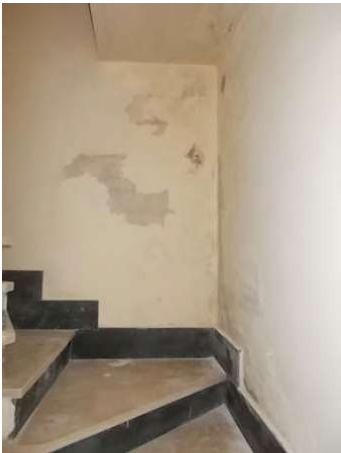
scala resa insalubre dalla diffusa presenza di infiltrazioni provenienti dal muro di contenimento della strada
