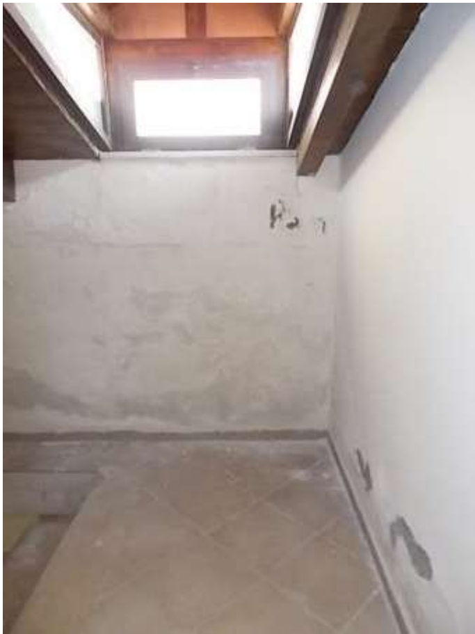
ambienti ultimo piano compromessi dalle infiltrazioni provenienti dai terrazzi e dal muro di contenimento della strada
