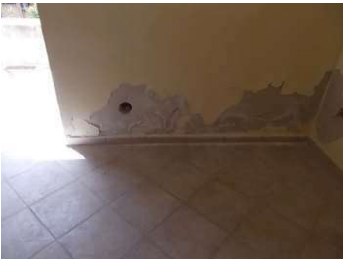
ambiente soggiorno-pranzo umidità ascendente in prossimità della zona ingresso
