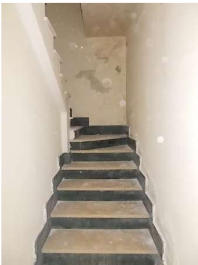
scala resa insalubre dalla diffusa presenza di infiltrazioni provenienti dal muro di contenimento della strada
