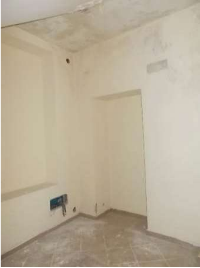
disimpegno d'ingresso al primo piano invaso dalle infiltrazioni
