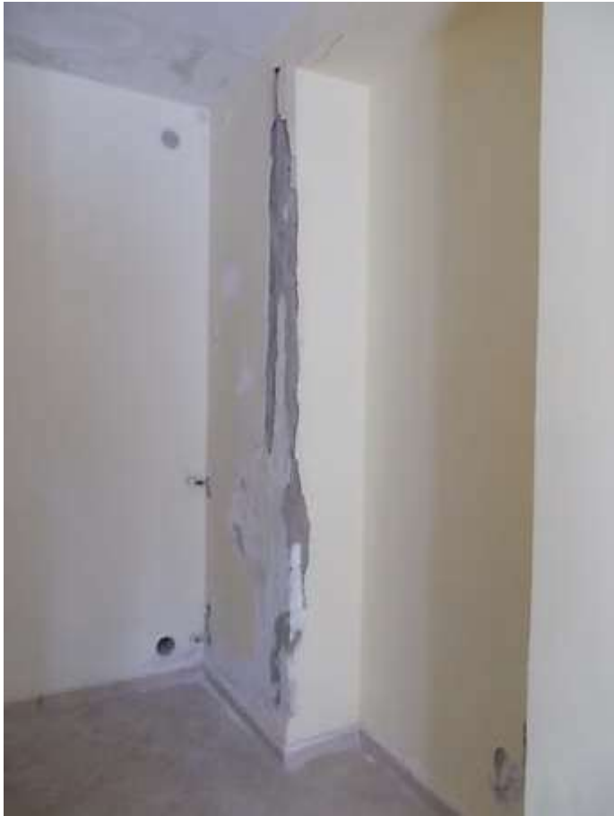
umidità ascendente ed infiltrazioni nel disimpegno al piano terra provenienti dal muro di contenimento della strada
