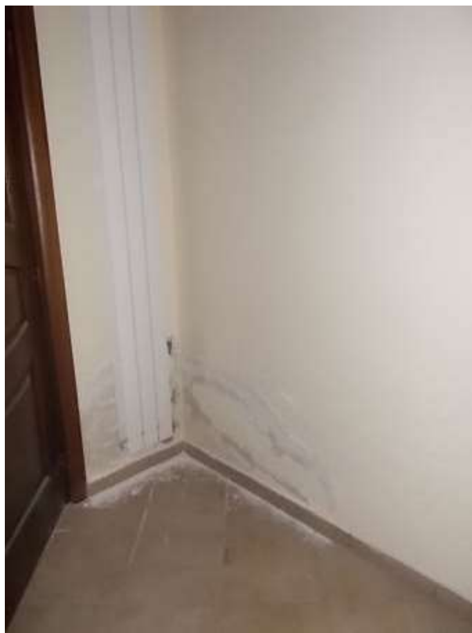
ambienti ultimo piano compromessi dalle infiltrazioni provenienti dai terrazzi e dal muro di contenimento della strada
