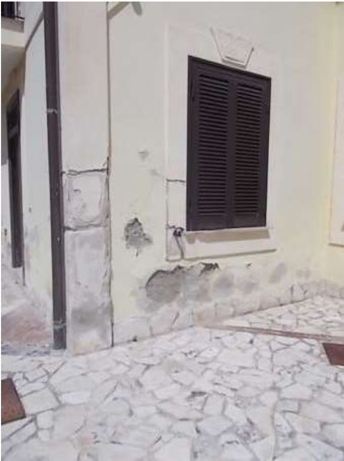
viste esterna ed interna dell'alloggio zona ingresso, si rilevano diffuse chiazze di umidità ascendente
