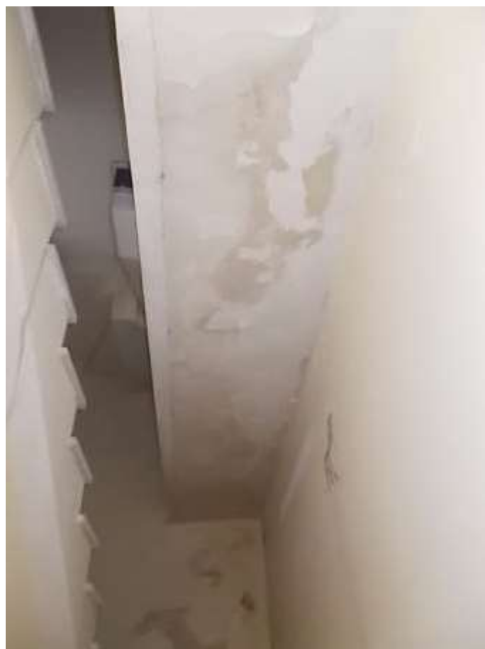
scala resa insalubre dalla diffusa presenza di infiltrazioni provenienti dal muro di contenimento della strada
