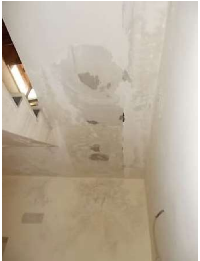
primo piano zona scala compromessa nelle finiture e nelle strutture dalle infiltrazioni
