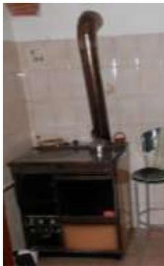
tipo, comprese, le opere di evacuazione dei prodotti della combustione e ventilazione e areazione dei locali. La stufa a legna installata nella cucina risulta collegata all'esterno mediante sistema di evacuazione dei fumi.
