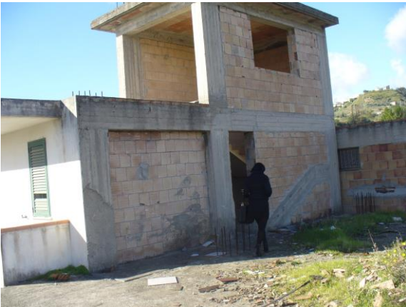
FOTO N. 15 – copertura frantoio - accesso pianerottolo P.1–
