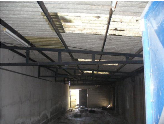
Foto n. 10 – interno corpo ad un piano f.t. –
