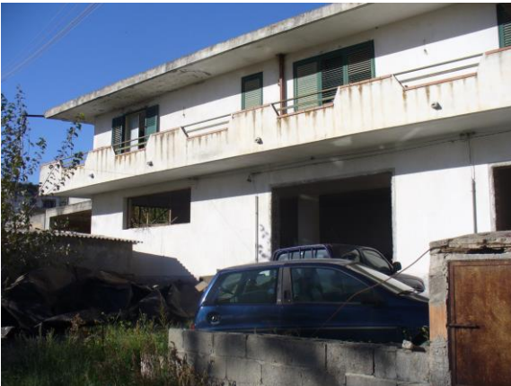
FOTO N. 16 – prospetto piano terra e primo –
