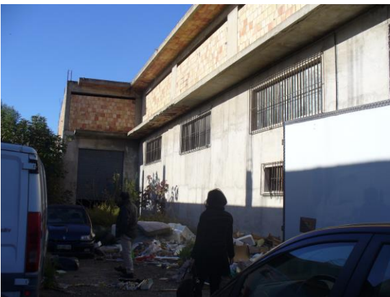
Foto n. 2 – prospetto lato mare –
