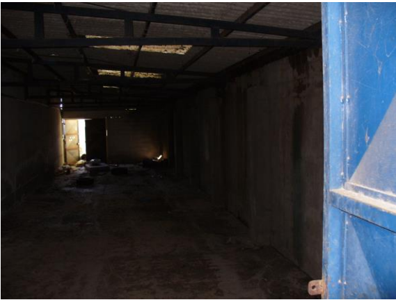
Foto n. 9 – interno corpo ad un piano f.t. –
