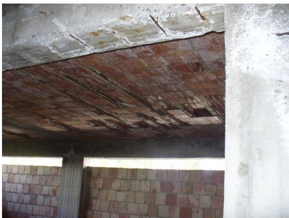
Foto n. 12 - particolare solaio piano primo –
