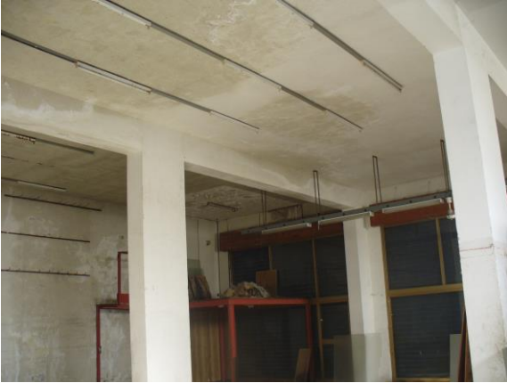
Foto n. 8 – interno piano terra – solaio –
