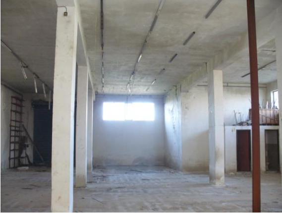
Foto n. 4 – interno piano terra –
