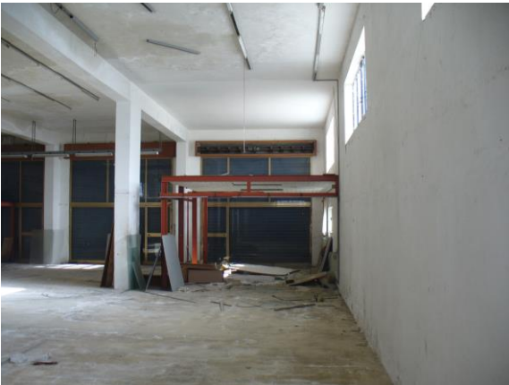
Foto n. 5 – interno piano terra –
