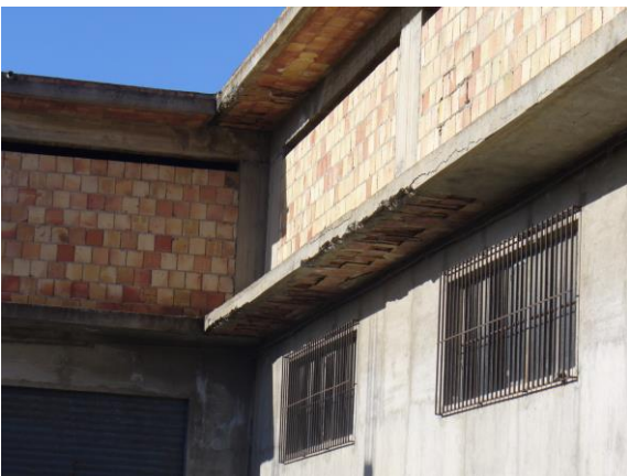
Foto n. 3 – particolare infisso e struttura balcone –
