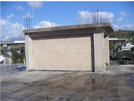
FOTO N. 17 – lastrico solare - abbaino –
