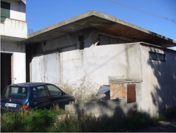
FOTO N. 14 – corpo di fabbrica destinato a frantoio –
