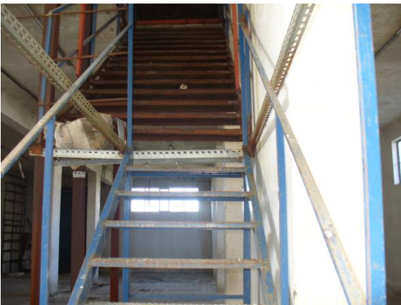
Foto n. 6 – interno piano terra – scala in metallo –
