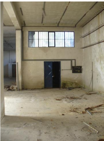
Foto n. 7 – interno piano terra – accesso corpo ad un piano f.t. –
