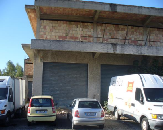
Foto n. 1 – prospetto lato strada -
