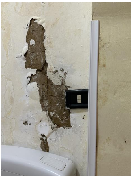
Infiltrazioni bagno piano terra
