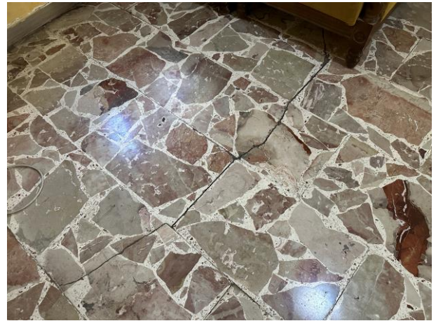
Lesione pavimento piano primo
