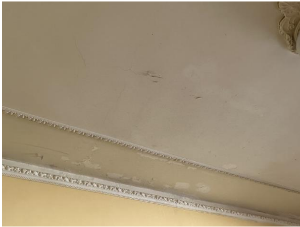
Infiltrazioni piano primo
