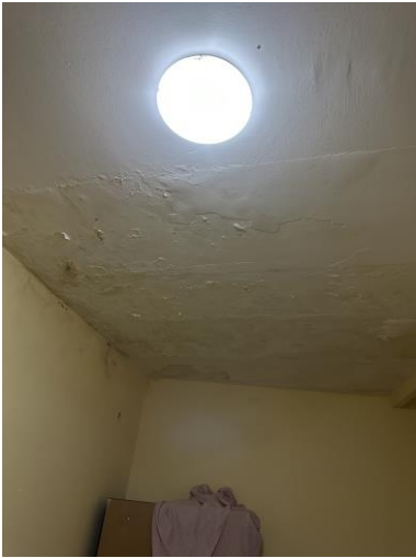
Infiltrazioni camere piano terra
