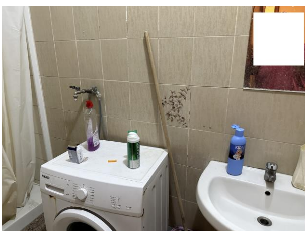
Bagno piano primo
