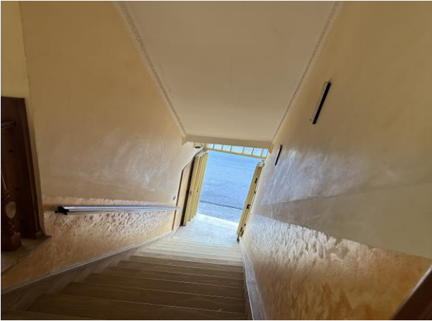
Scala di accesso al piano primo
