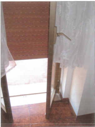
PORTA FINESTRA DISIMPEGNO ZONA NOTTE
