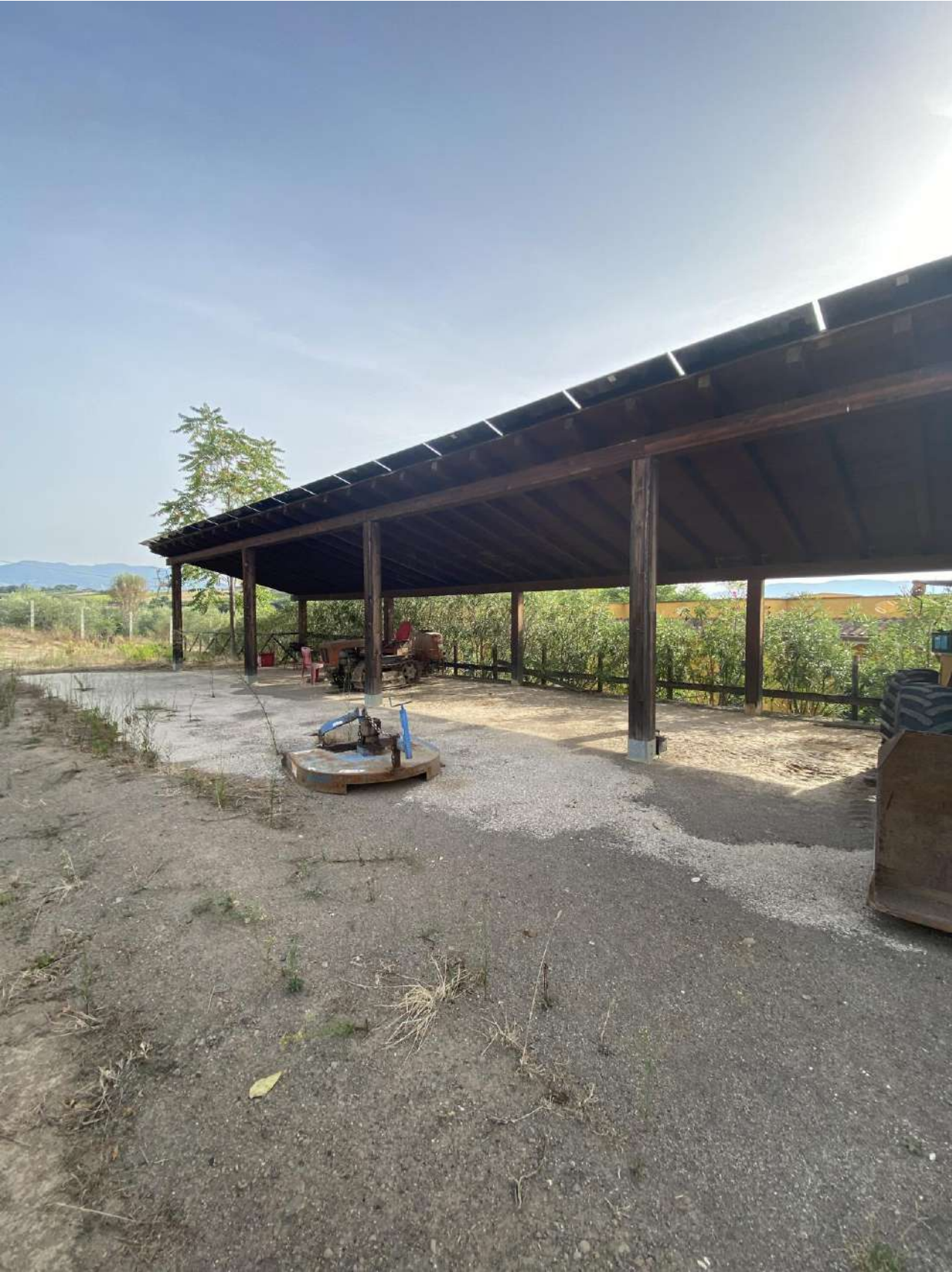
15) Area esterna posteriore mini alloggi albergo, tettoia fotovoltaica
