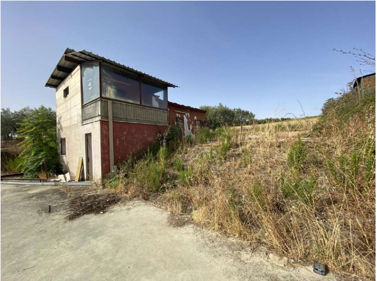
23) Prospetto frontale magazzino
