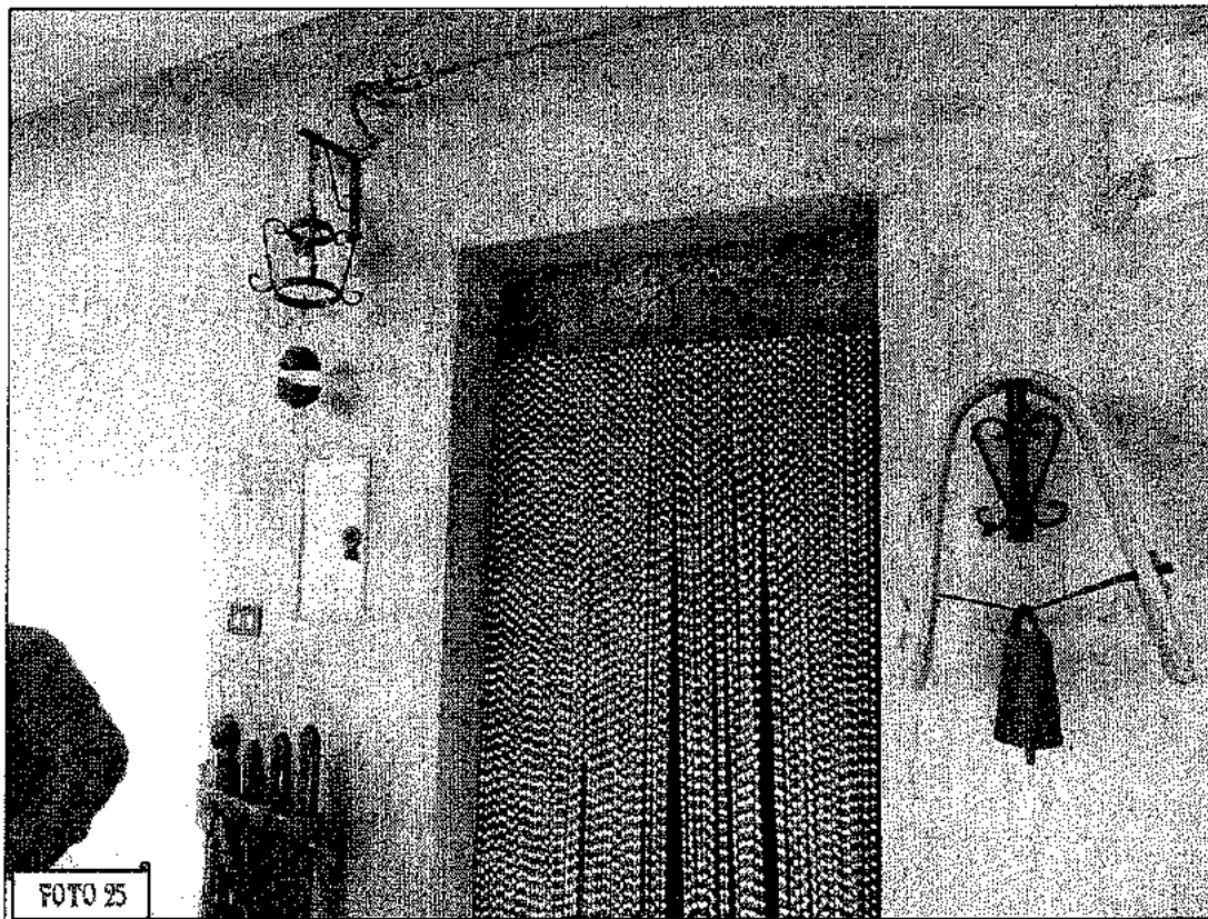
Porta d'accesso alla "cucina rustica", ricavata sul fronte meridionale del manufatto, al piano terra.
