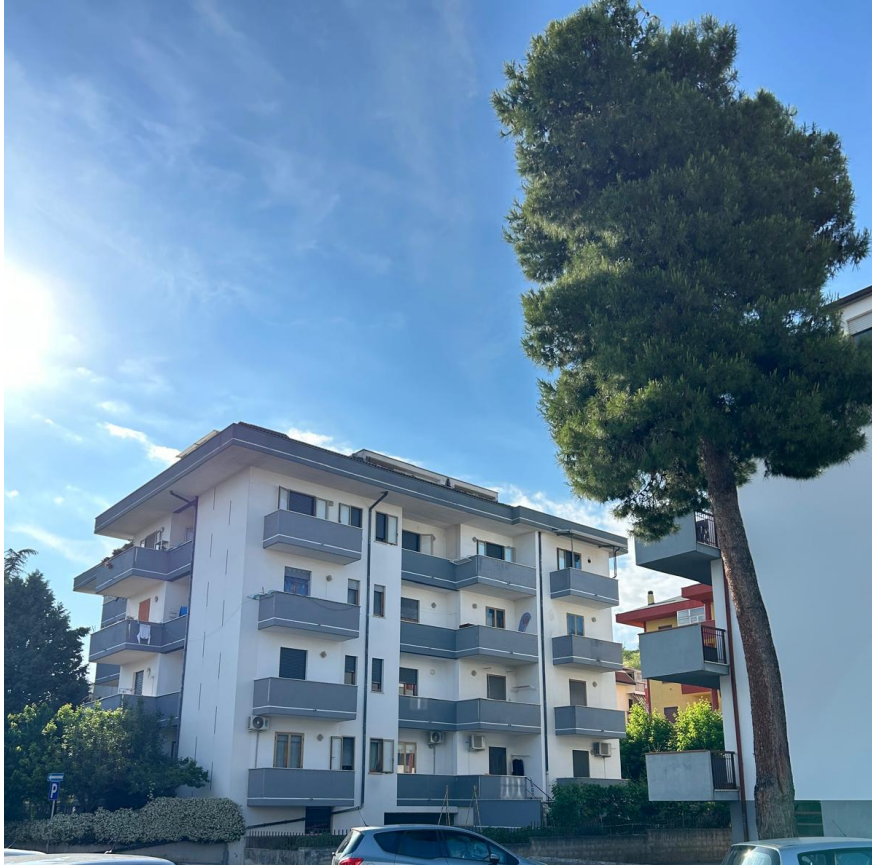
Foto 01 – Vista esterna palazzina
