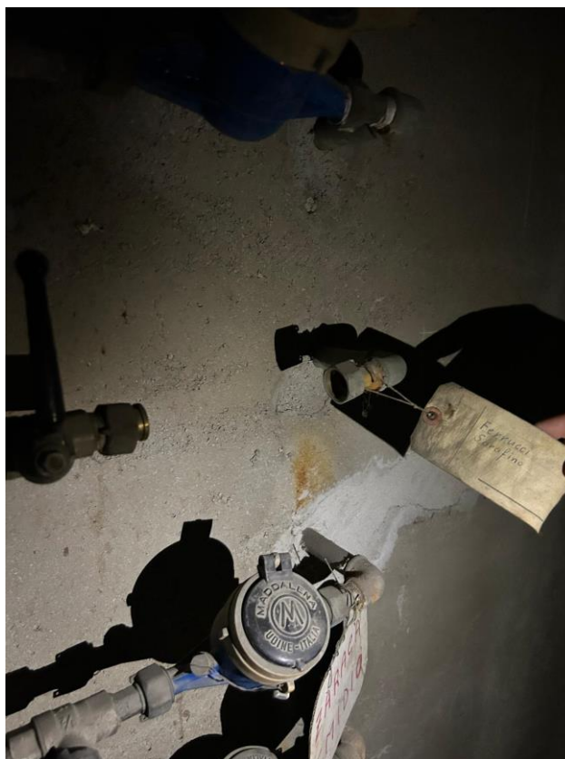
Foto 16 – Contatore acqua staccato
