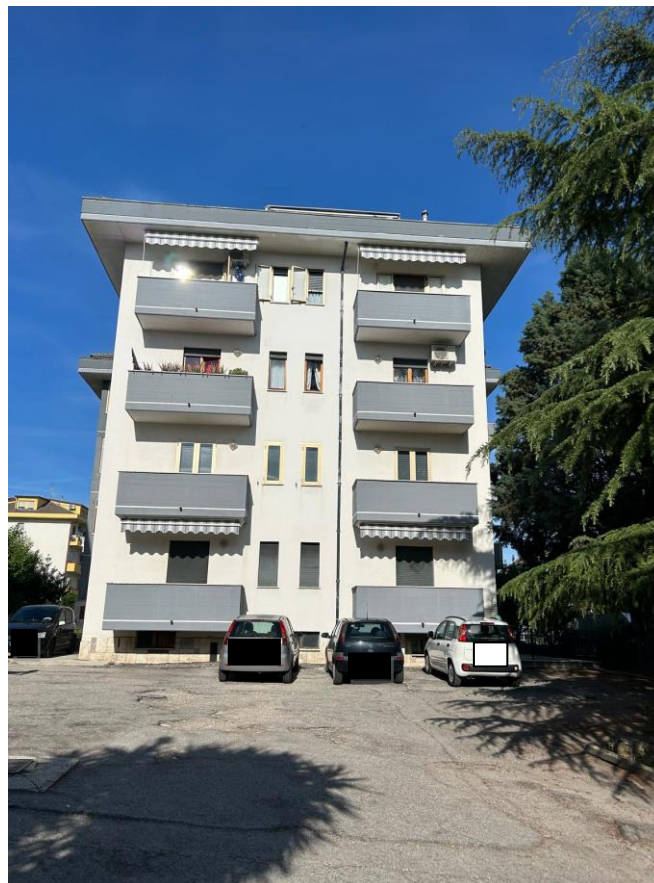
Foto 01 – Vista esterna palazzina
