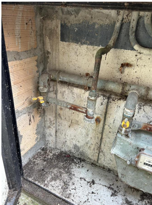
Foto 15 – Contatore metano staccato
